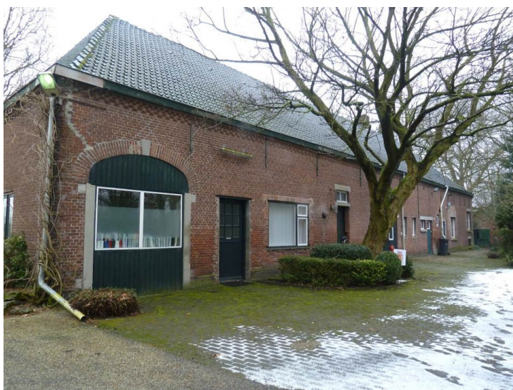
De achtergevel van de boerderij. De gevelindeling is sterk gewijzigd.
