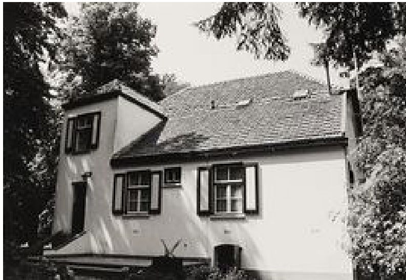
De achterzijde van het huis voor de renovatie in de jaren '90.
