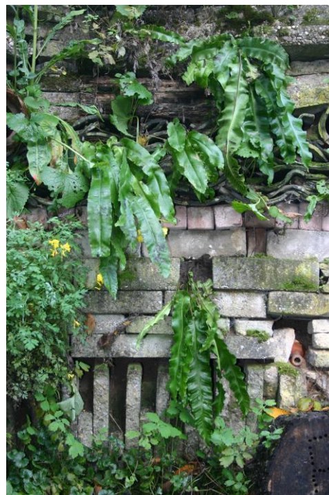
Figuur 5.1.3. Voorbeeld van een keermuur met enkele verplaatste tongvarens.
