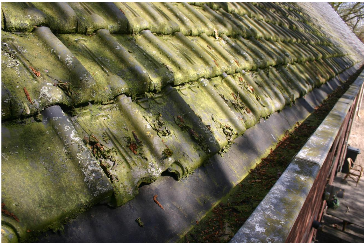
Figuur 4.2.2. In het dak van de langgevelboerderij is geen ruimte voor vogelnesten.
