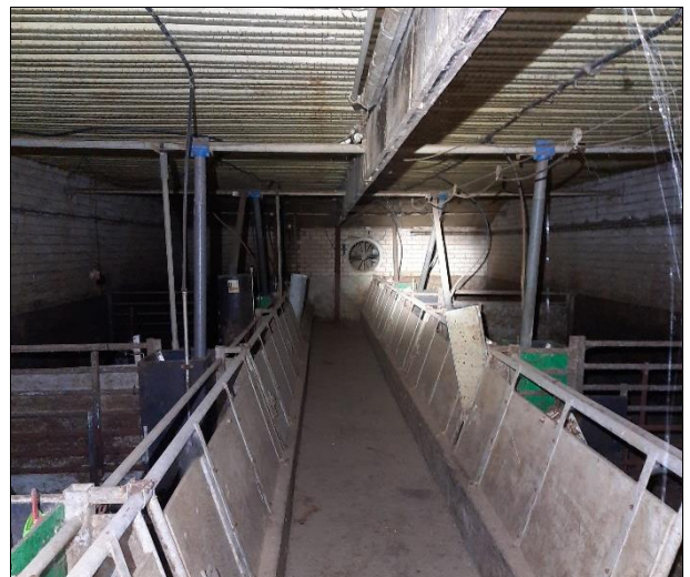
Foto 6 Impressie van de binnenzijde van de varkensstal.
