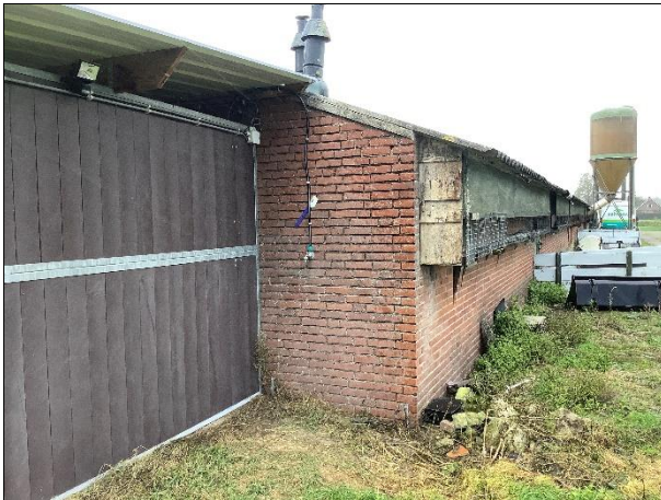
Foto 3 De oostelijke gevel van de varkensstal met links de oostelijke gevel van de paardenboxen.
