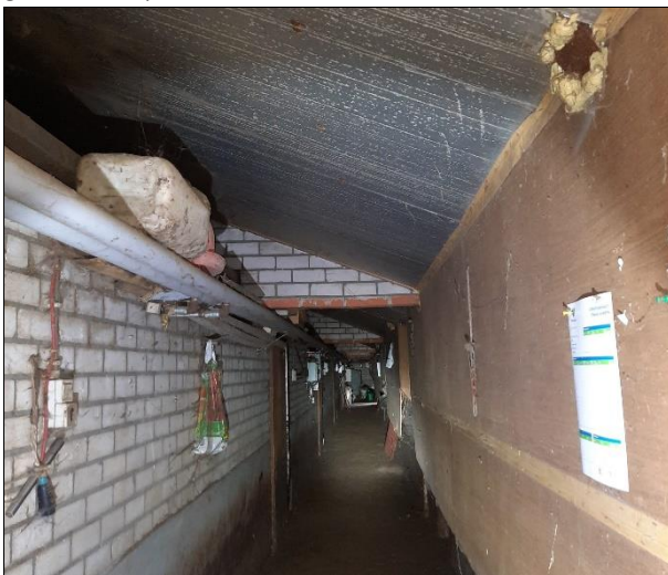
Foto 5 Impressie van de binnenzijde van de varkensstal.
