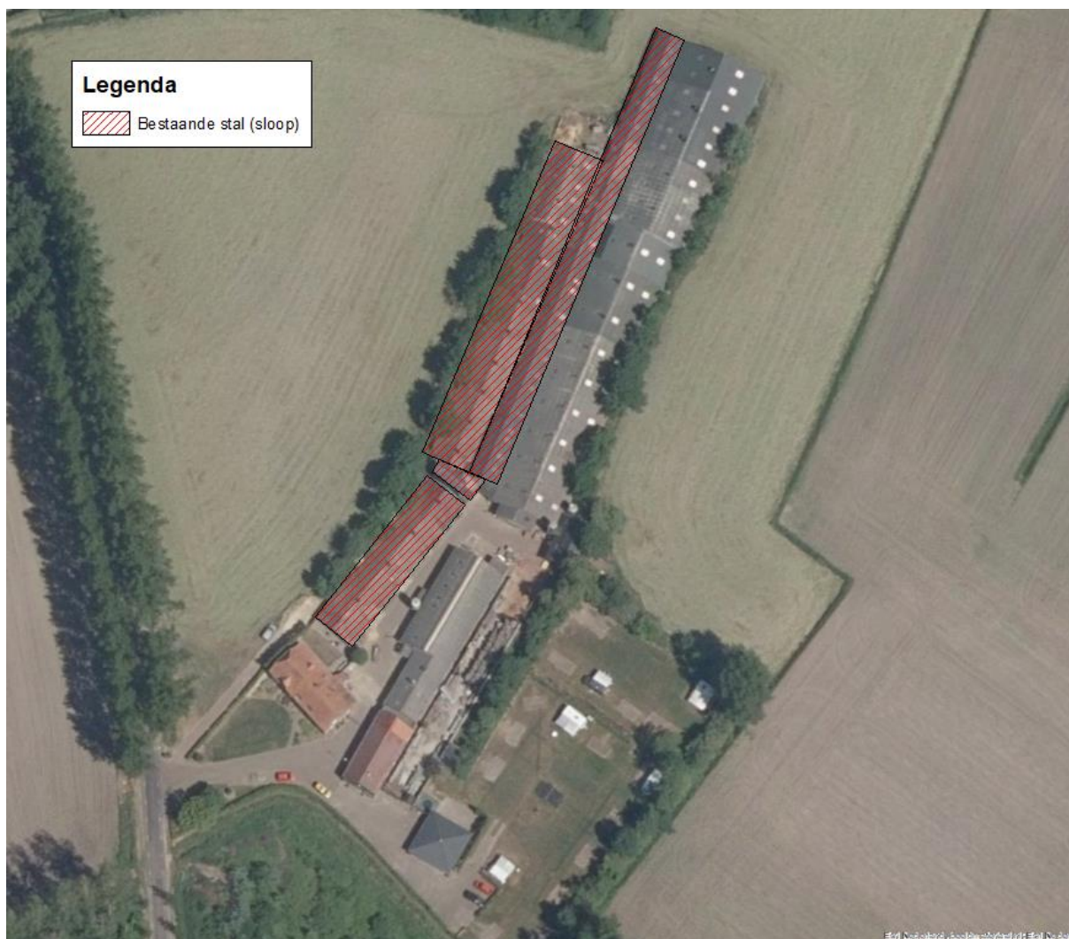
Figuur 2-1: Te slopen bebouwing
