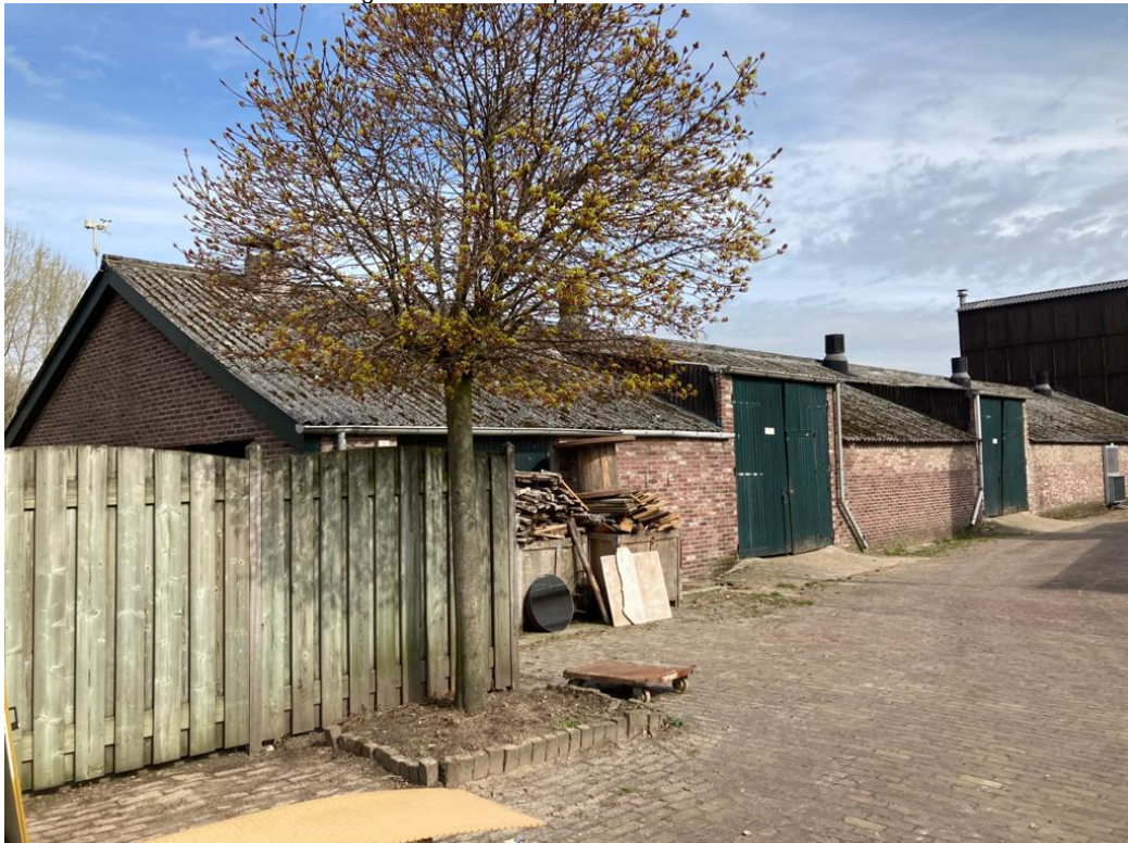
• Afbeelding 19: aanzicht te slopen stallen
