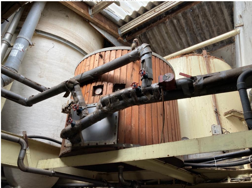
• Afbeelding 7: te slopen voerkeuken
