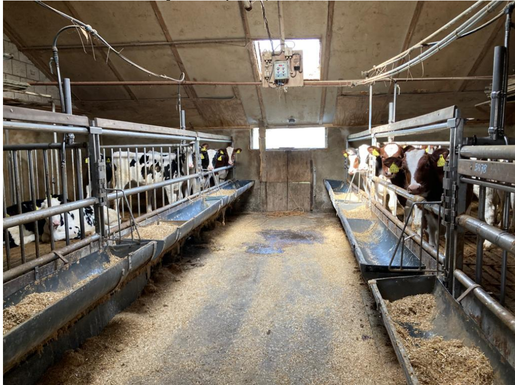
• Afbeelding 10: binnenzijde te slopen kalverenstal
