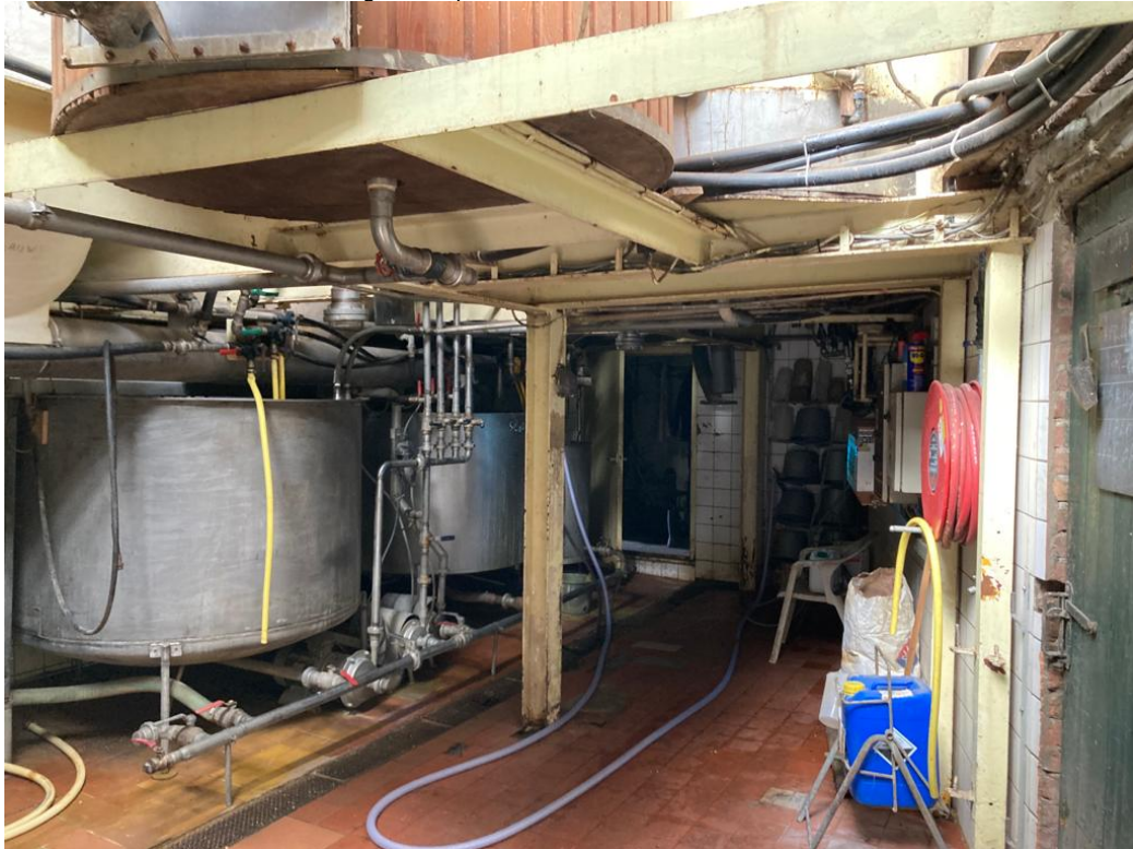
• Afbeelding 8: te slopen voerkeuken
