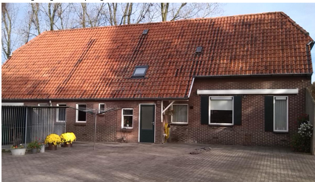
Figuur 4.3 de langgevelboerderij Donte 8 gezien vanaf de zuidkant.
