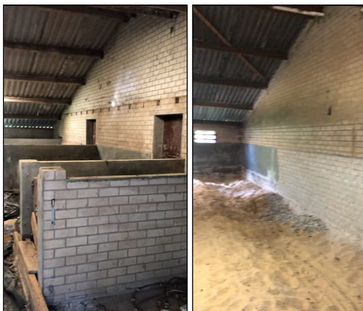
Figuur 23: Binnenzijde bestaande bebouwing
