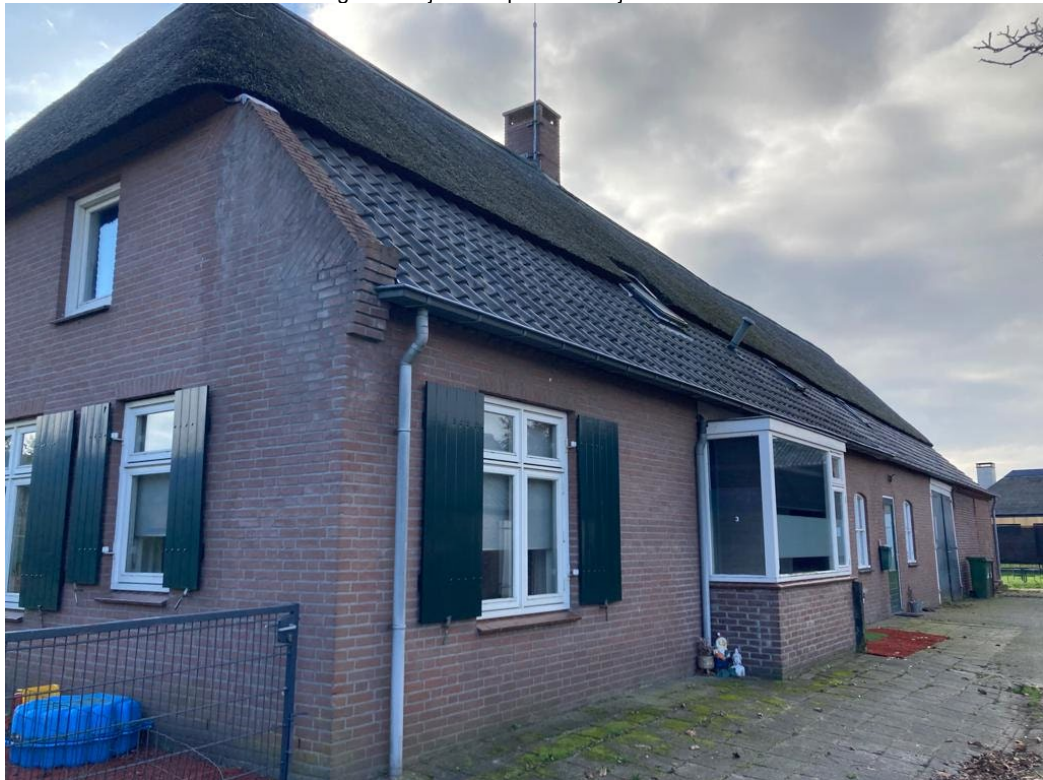
• Afbeelding 3: voorzijde te slopen boerderij
