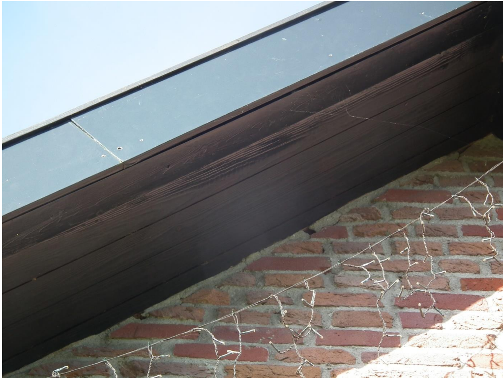
Figuur 3 De gevelafwerkingen en het dak sluiten nauw aan op elkander waardoor er geen sprake is van openingen, gleuven, holtes of andere voor vleermuis geschikte ruimtes.
