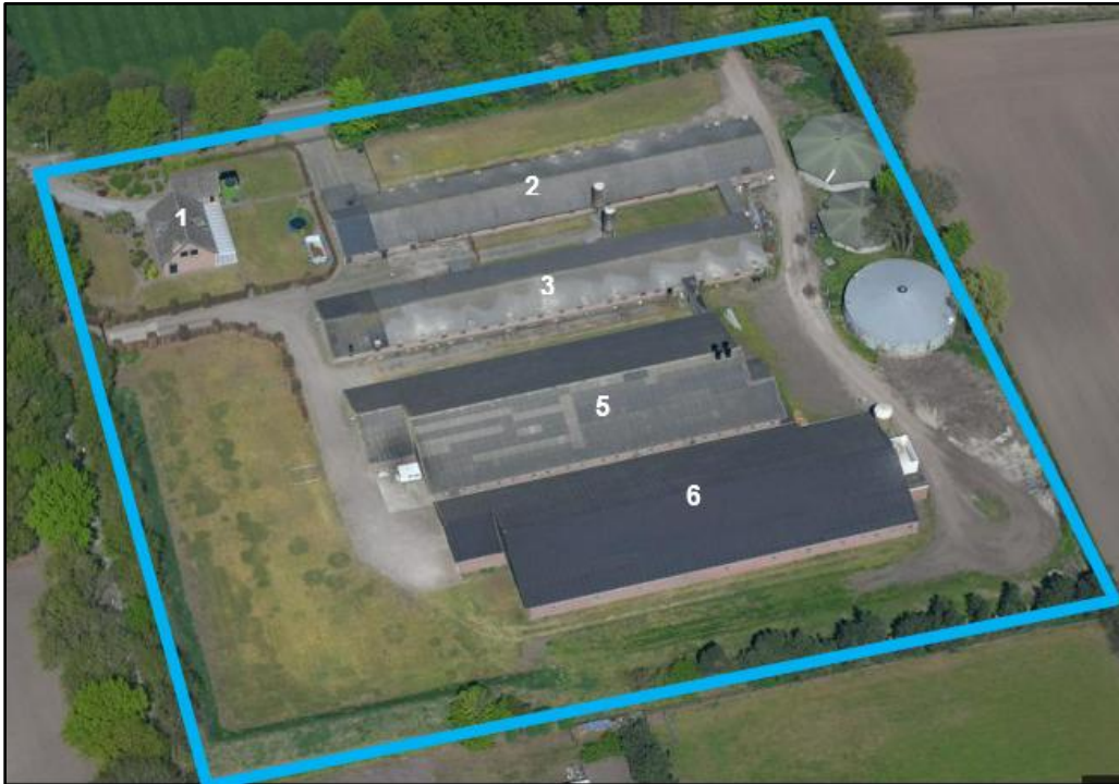
Afbeelding 3. Luchtfoto huidige situatie plangebied.
