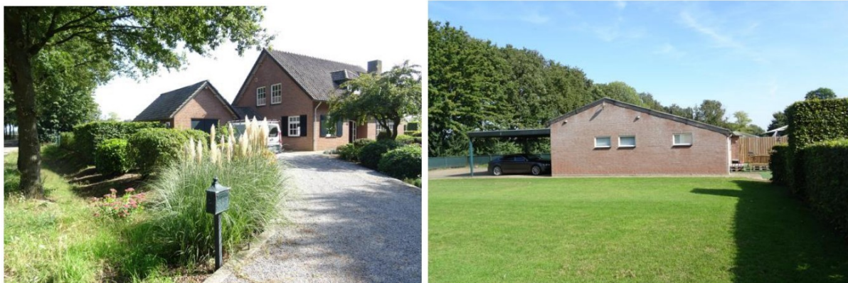
Afbeelding 9 en 10: De woning en bijgebouw op de kavels. Bron: BNL advies, datum: 22-09-2021
