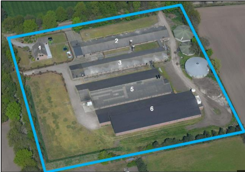
Afbeelding 3. Luchtfoto huidige situatie plangebied.
