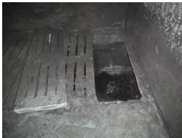
Inspectie putten en vloeren. Betonnen roosters opgetild.
