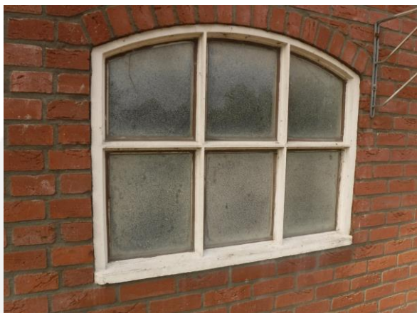
Glaszetting niet asbestverdacht.
