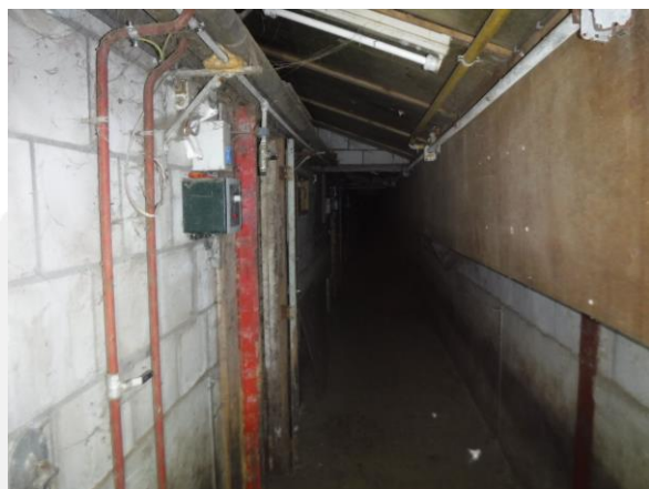
Centrale gang: houten winddrukcap. Muren van kalkzandblokken. Onverdacht leidingwerk. Stalen spanten zichtbaar.
