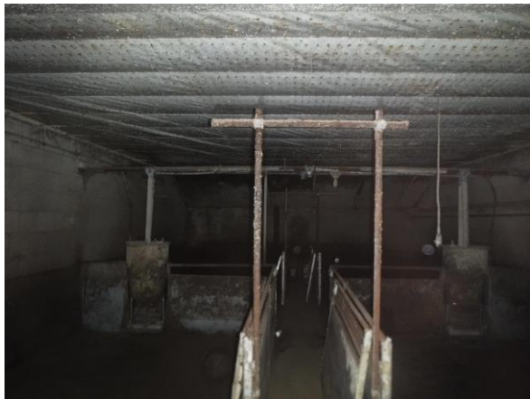
Gesloten dakisolatie van dupanel met plastic ventilatiefolie.
