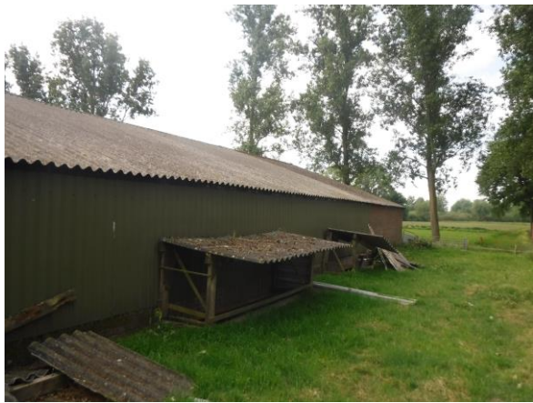
Zijgevel stal 1 achterste gedeelte met luchtinlaten.
