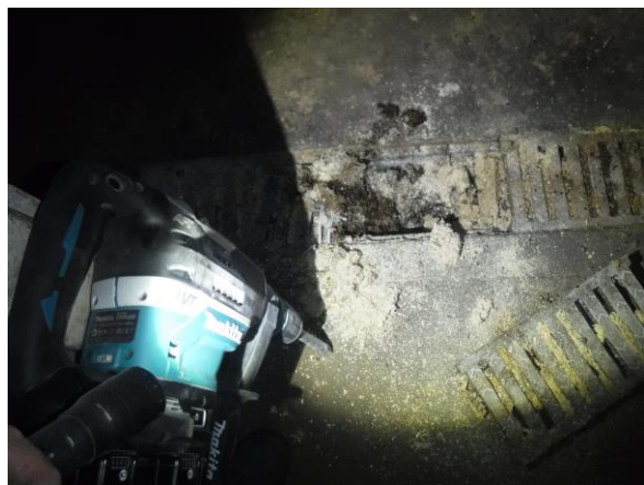
Vloerinspectie in de gangen.
