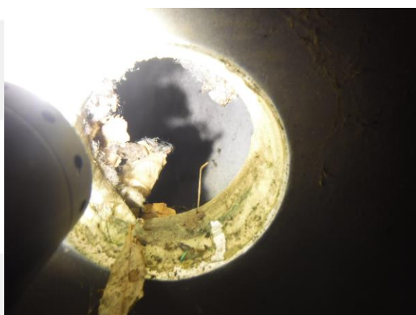
Inspectie achter isolatie: golfplaten zichtbaar.
