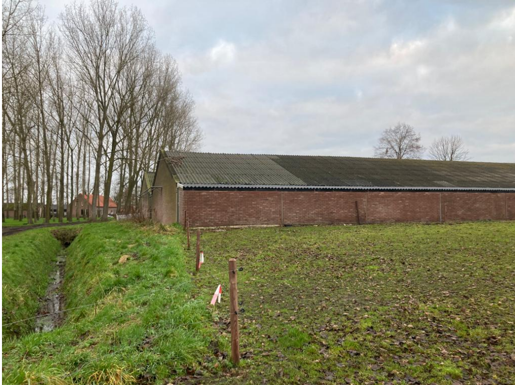
• Afbeelding 12: zij aanzicht te slopen gebouwen
