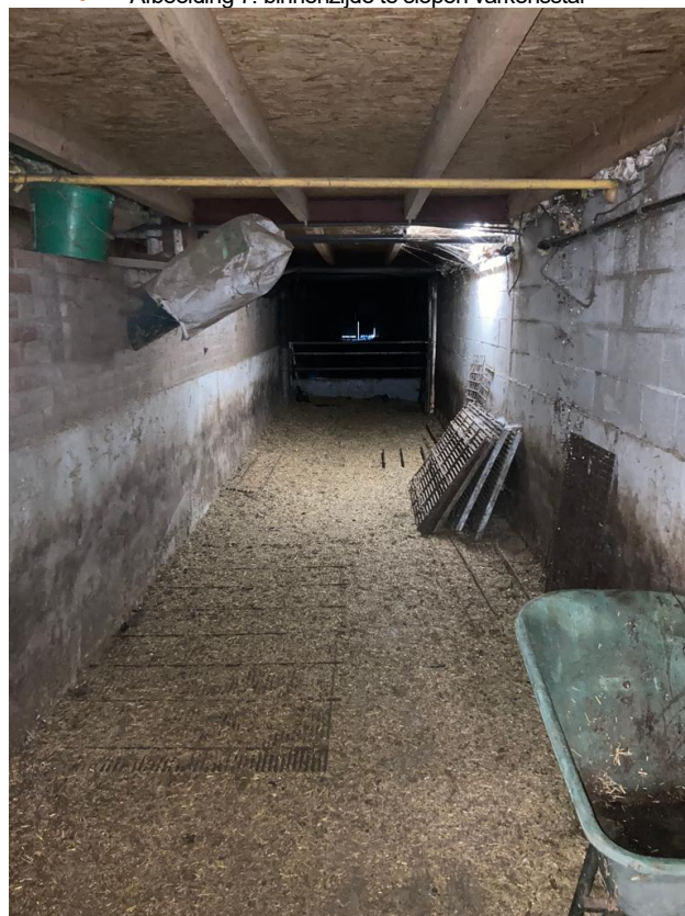
• Afbeelding 7: binnenzijde te slopen varkensstal
