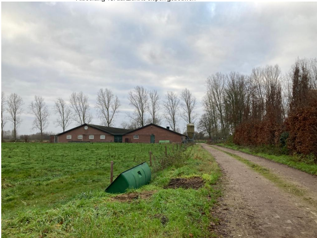
• Afbeelding 13: aanzicht te slopen gebouwen
