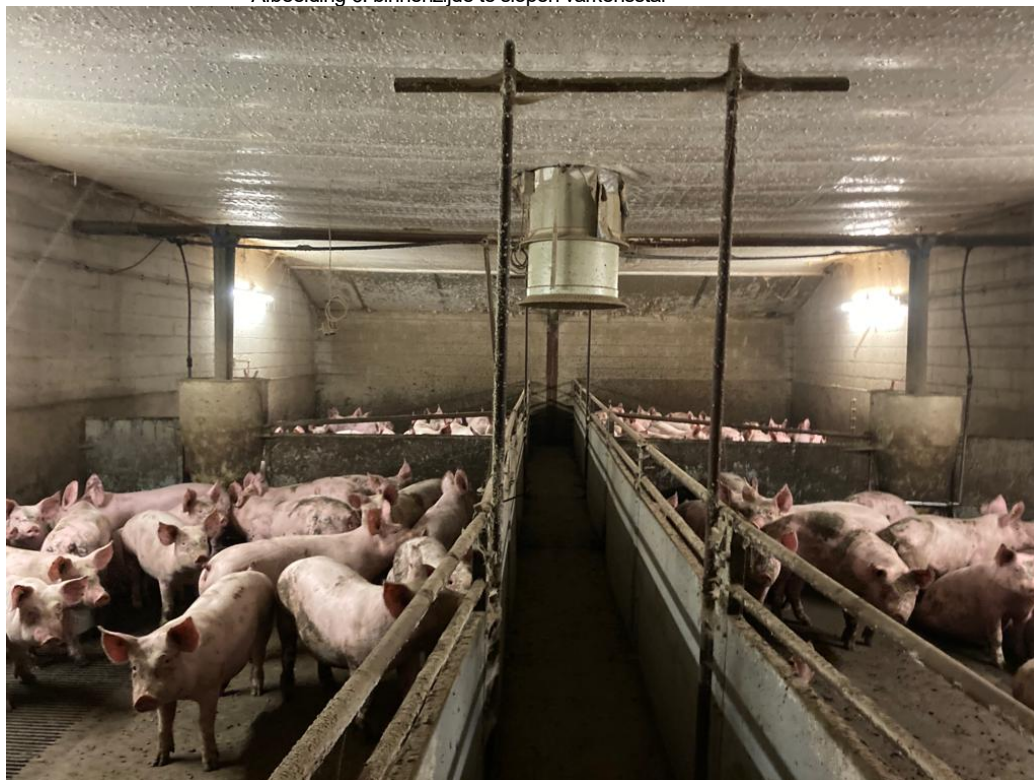
• Afbeelding 6: binnenzijde te slopen varkensstal
