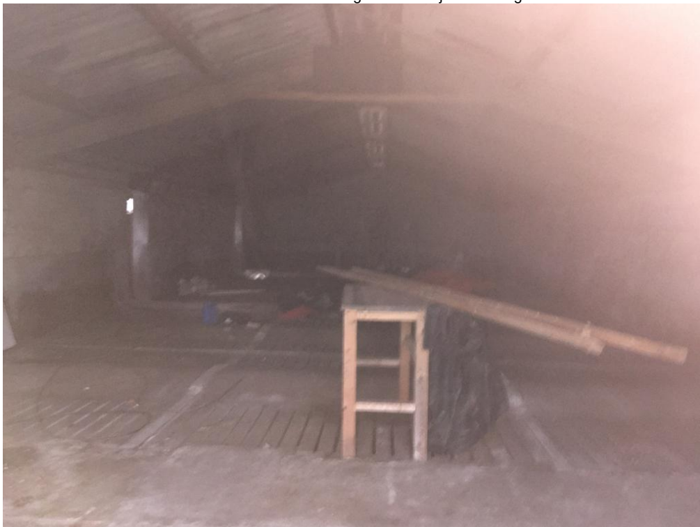
• Afbeelding 22: binnenzijde voormalige varkensstal
