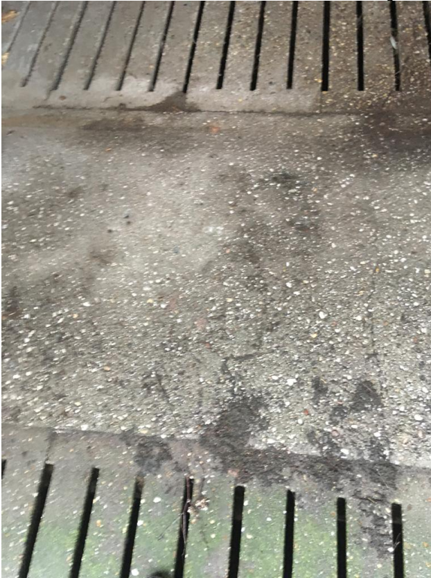
• Afbeelding 19: rooster te slopen bedrijfsgebouw
