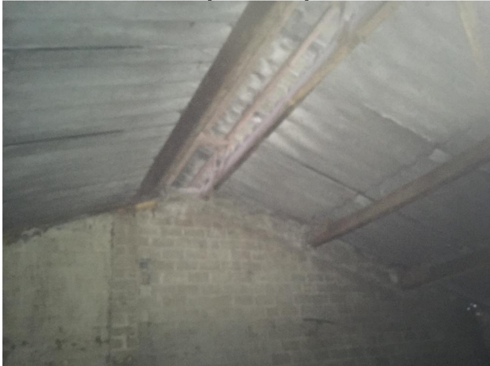
Afbeelding 29: dak van voormalige varkensstal
