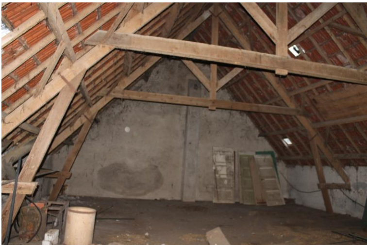
De verbeterde Hollandse spanten op het bedrijfsgedeelte met op de achtergrond de brandmuur
