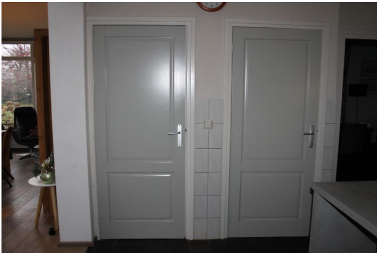
Toegangen tot de verdieping en opkamer (linkerdeur) en kelder (rechter deur). Links van de deuren de latere aanbouw en rechts van de deuren de toegang tot de woonkamer.
