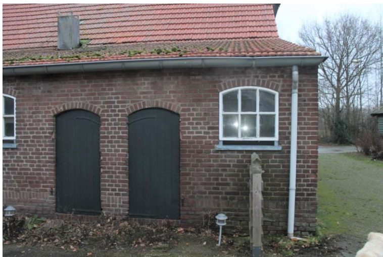
Oorspronkelijke varkensdeuren en betonnen stalvenster uit de Bouwtijd
