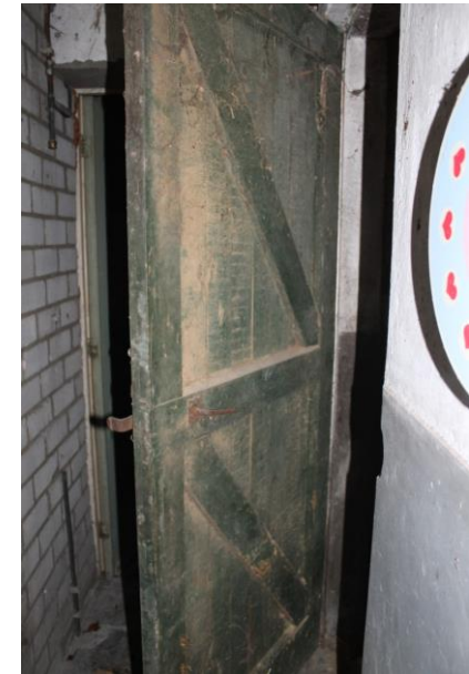
Oorspronkelijke toegang tot varkensstal
