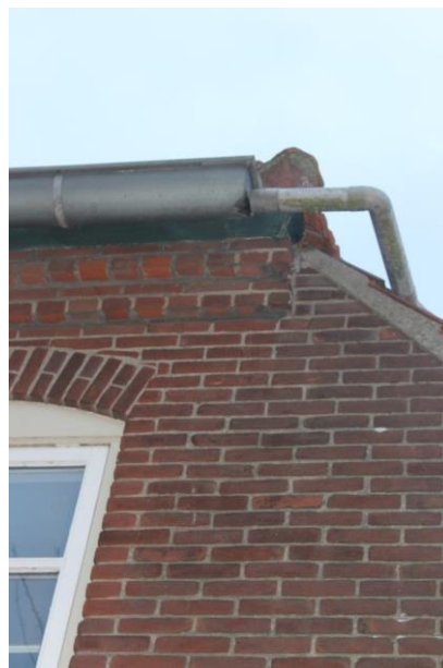
Siermetselwerk onder gootlijn
