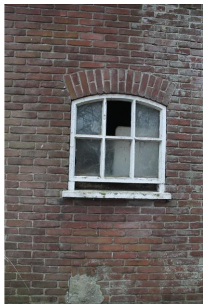
Betonnen stalvensters
