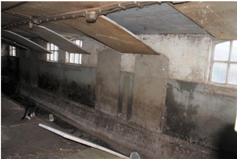
De verbouwde varkensstal in de uitbouw
