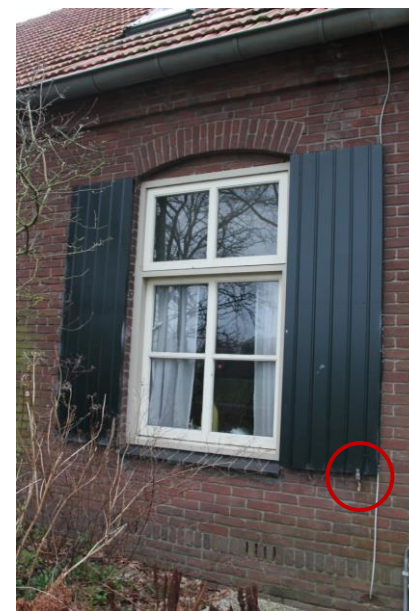
Linker venster met in cirkel oorspronkelijke luikwervel
