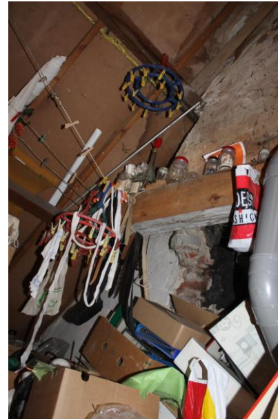
Het deels verwijderde rookkanaal
