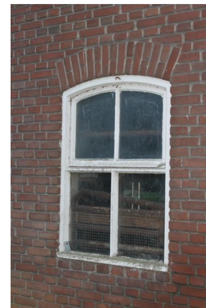
Oorspronkelijk betonvenster met betonnen kiepraam
