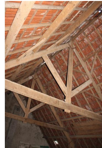
Makelaar met steekschoren en trekplaat
