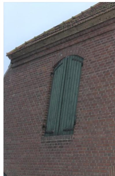
Oorspronkelijke hooiluik en siermetselwerk onder het wolfseind
