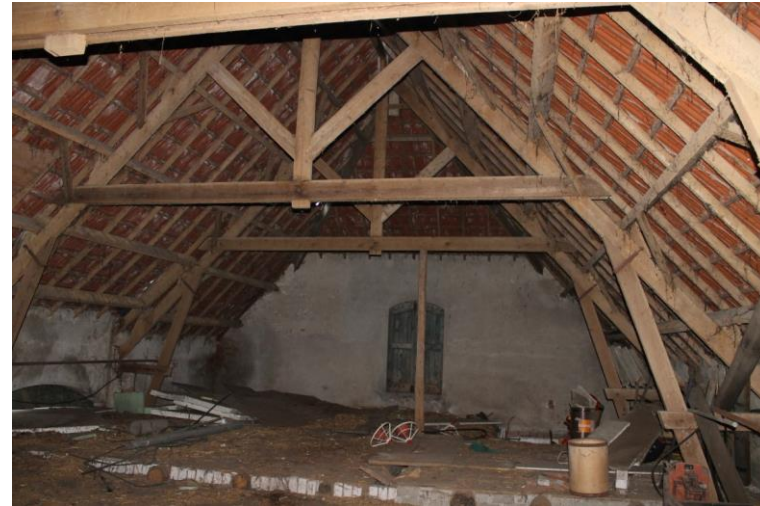
Op de achtergrond het oorspronkelijk opgeklampte hooiluik
