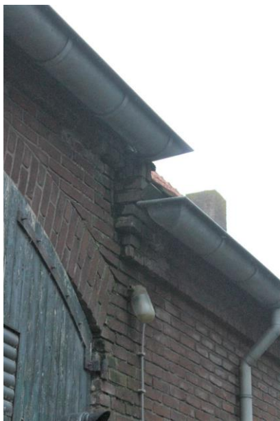
Gootverhoging boven deeldeuren
