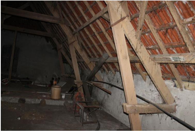
Aansluiting van kreupele stijl met de buitenmuur
