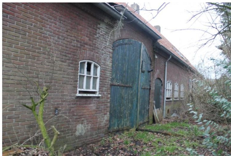
Voorgevel van het bedrijfsgedeelte
