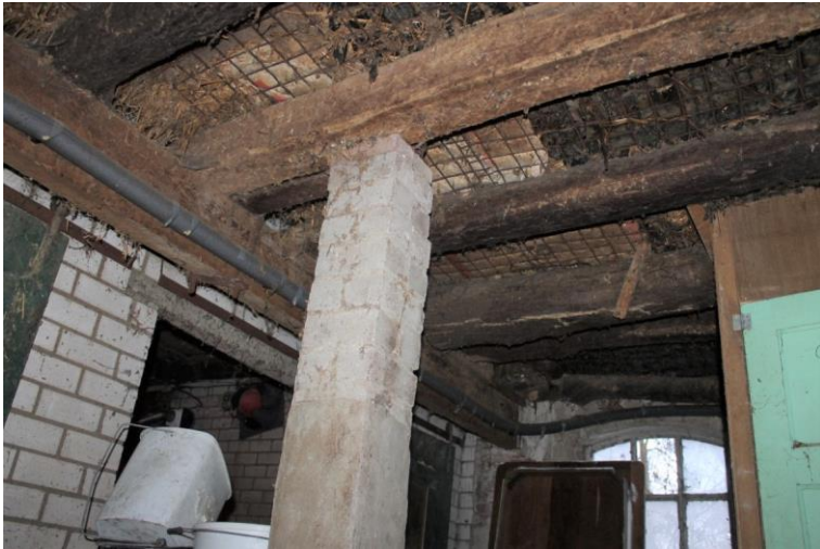
De later aangebrachte verdiepingsvloer met links de aangebrachte ruimte achter de deeldeuren
