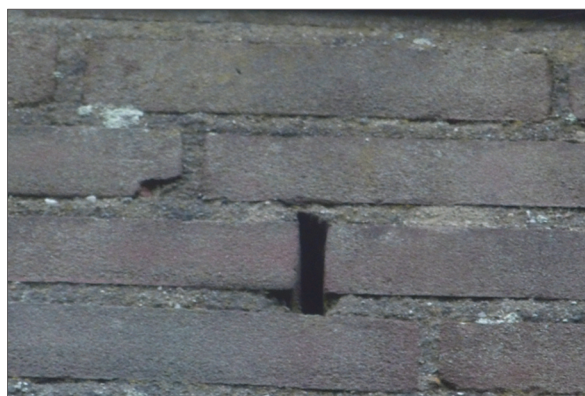
Figuur 4. Open stootvoegen in westelijke muur
