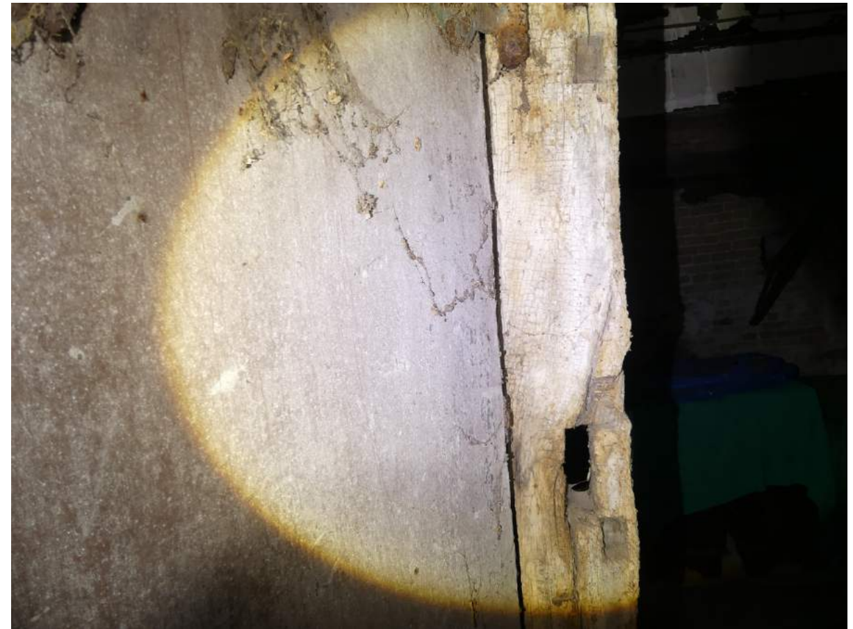
Afb. 16: mogelijk een stijl van de originele hallehuisboerderij
