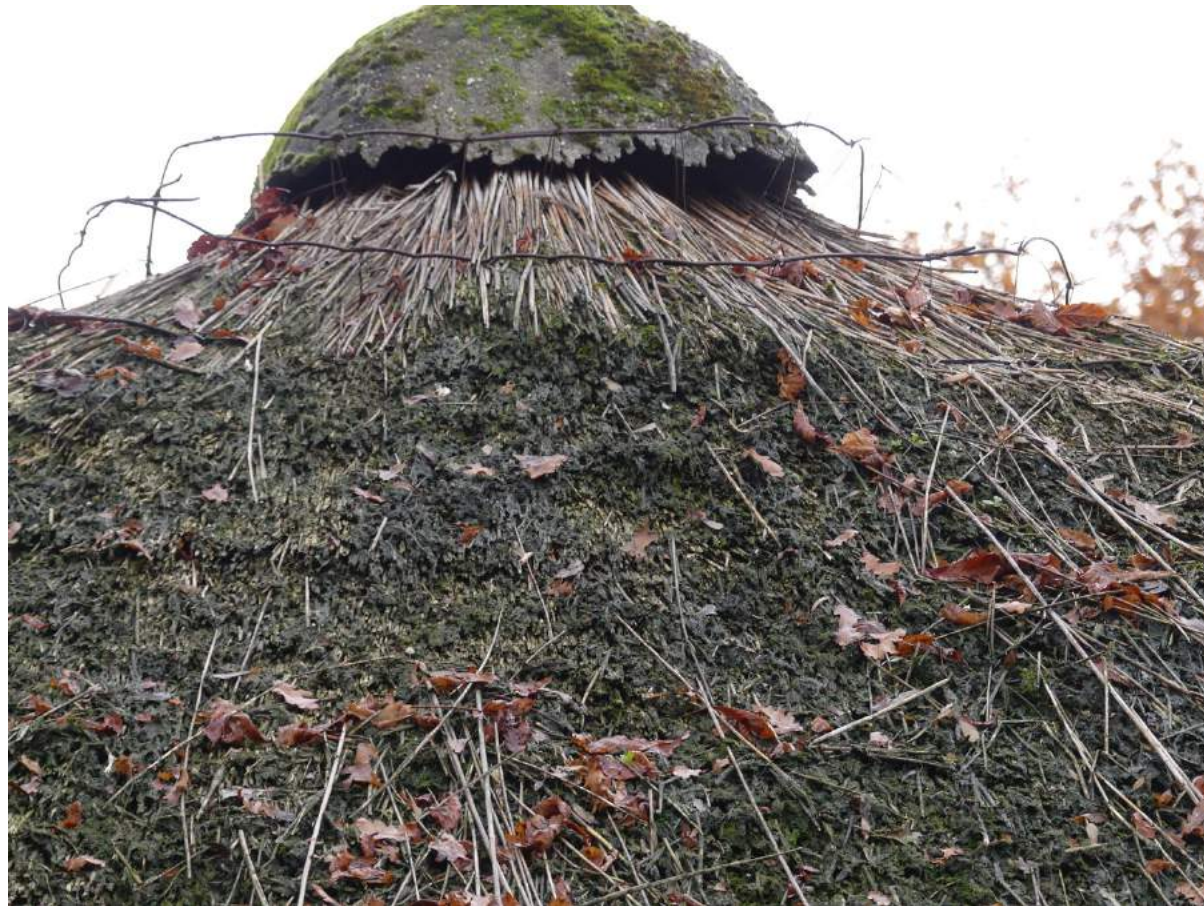
Afb. 5: versleten riet, roestige binddraden!
