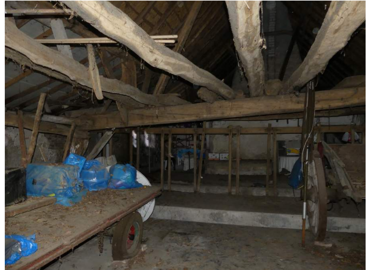
Afb. 19: overzicht linkerhelft gebintstel met ruw afgebeilde eiken slieten
