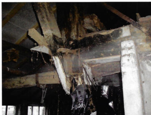
Kalk op het onderste deel van het gebint.
