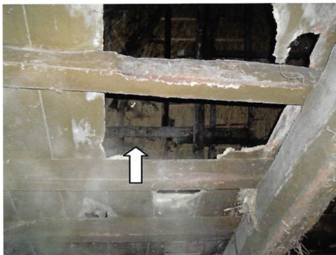
Herbruikte balk in kap met een reeks van gaten, deze dienen gedetailleerd uitgetekend te worden ten einde de oorsprong vast te kunnen stellen. Het kan een balk uit de vakwerkperiode zijn.
