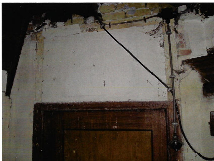
Bovenzijde deurkozijn met biljoen.
