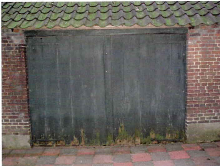
Nieuwe poort in de zijgevel.
