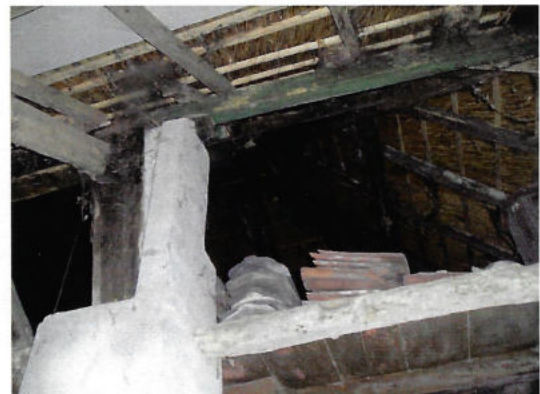
Stijl eerste gebint ommetseld
