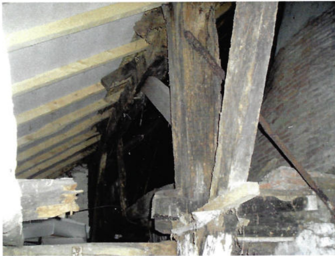
De wijziging dakbelasting en ontbreken stijl, opgevangen door stalen trekstaaf.
