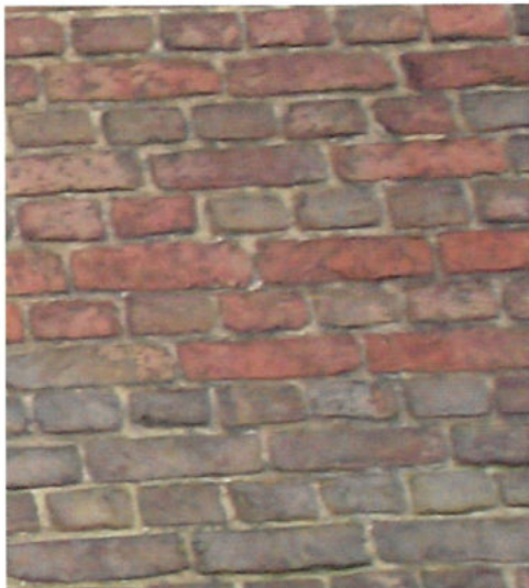
Twee soorten metselwerk op elkaar (kopgevel)
