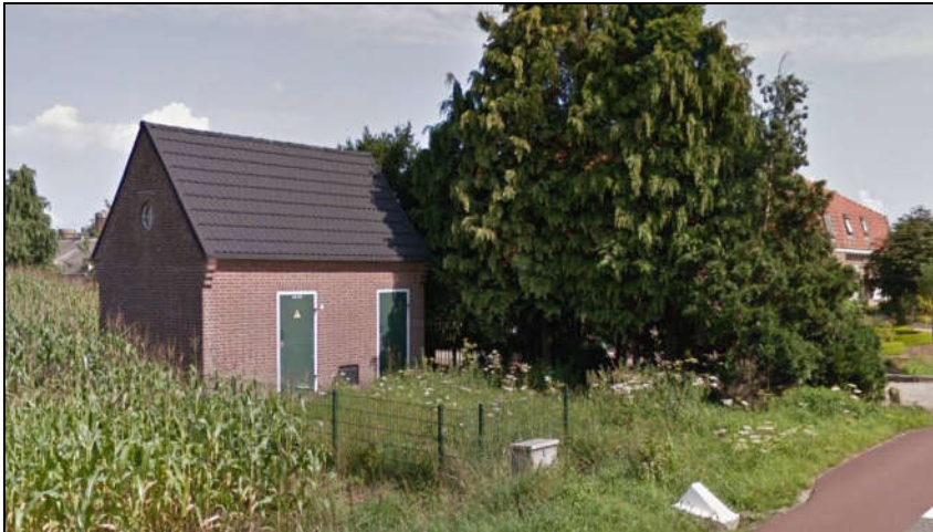
Figuur 27: Beeld transformatorhuisje ten westen van plangebied (bron: Google Maps)
