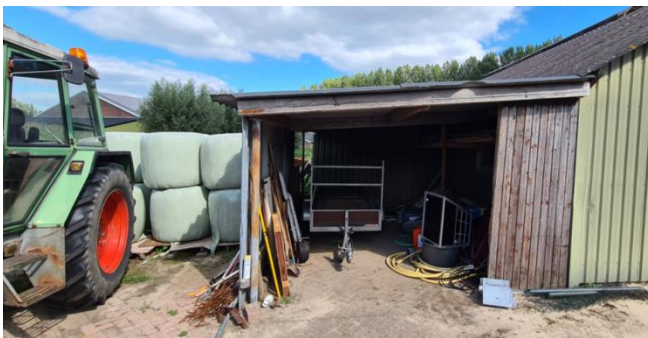
Figuur 7: Schuur aan achterzijde stallen, gezien vanuit het westen
