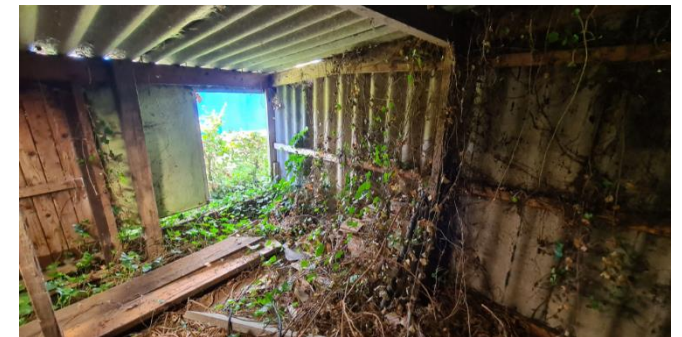
Figuur 6: Binnenzijde van schuur direct achter het woonhuis
