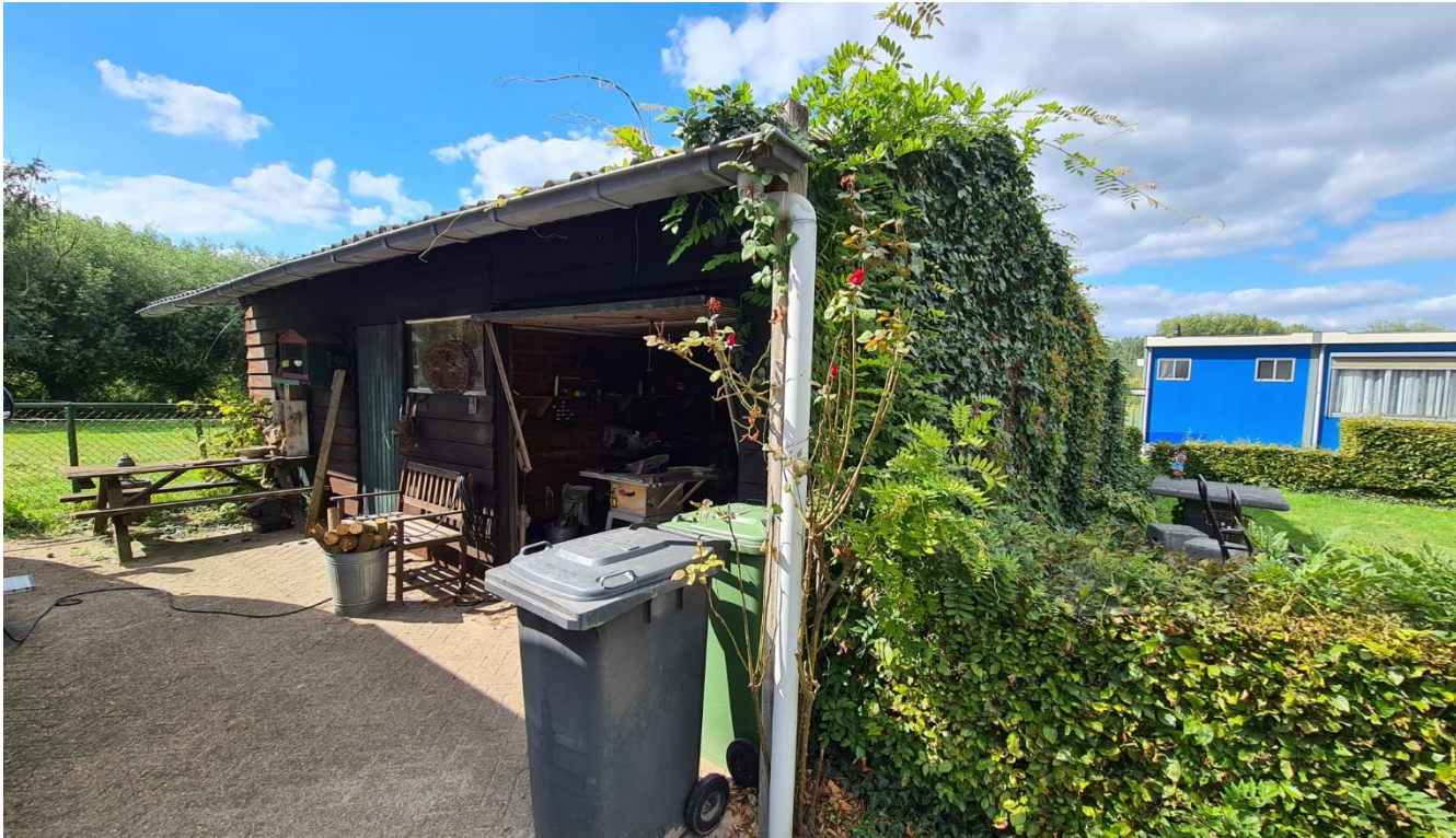
Figuur 4: Schuur direct achter het woonhuis
