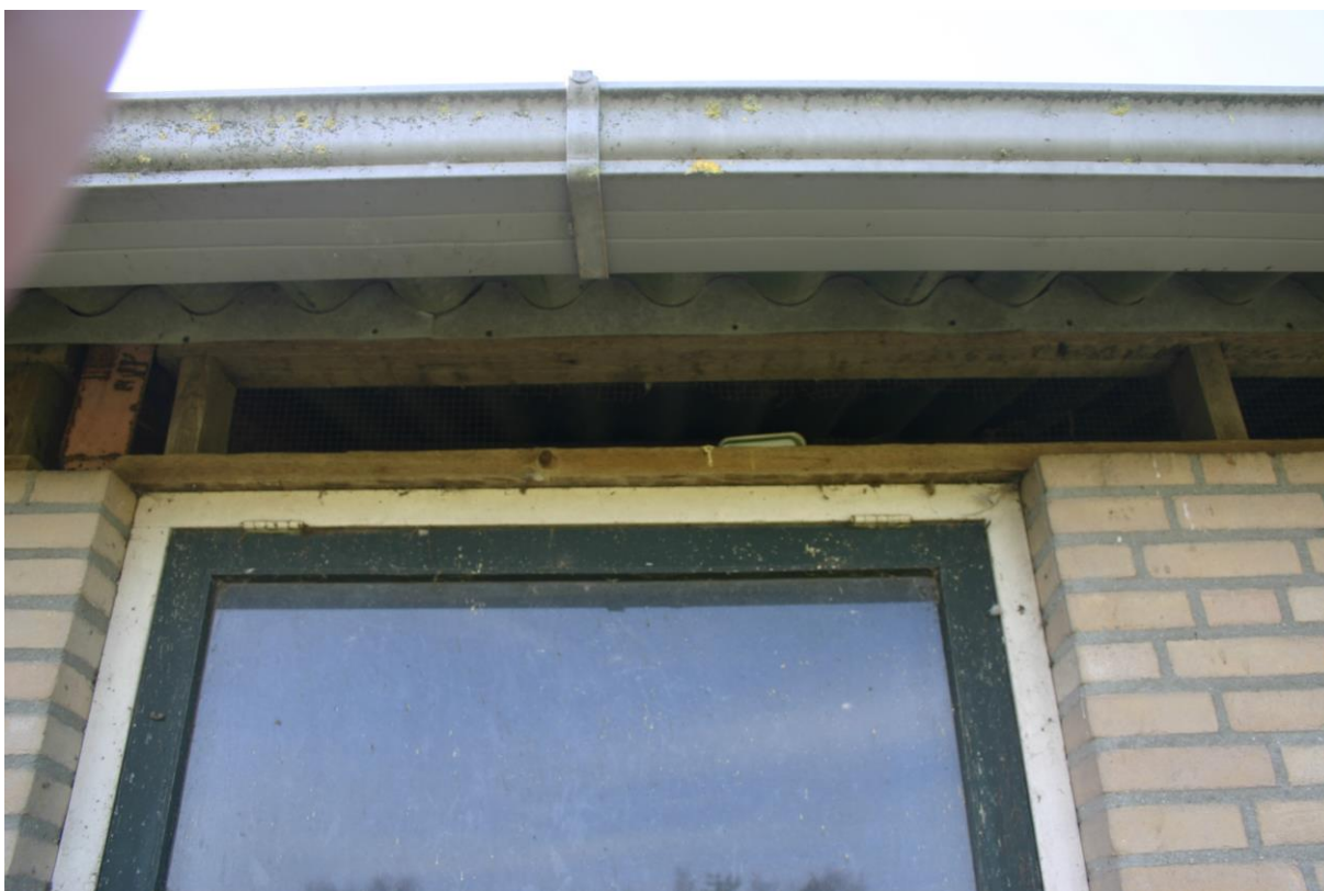
Figuur 6. De openingen onder de eternieten golfplaten van stallen 2 en 3 zijn gedicht en de onderliggende openingen zijn afgezet met gaas.
