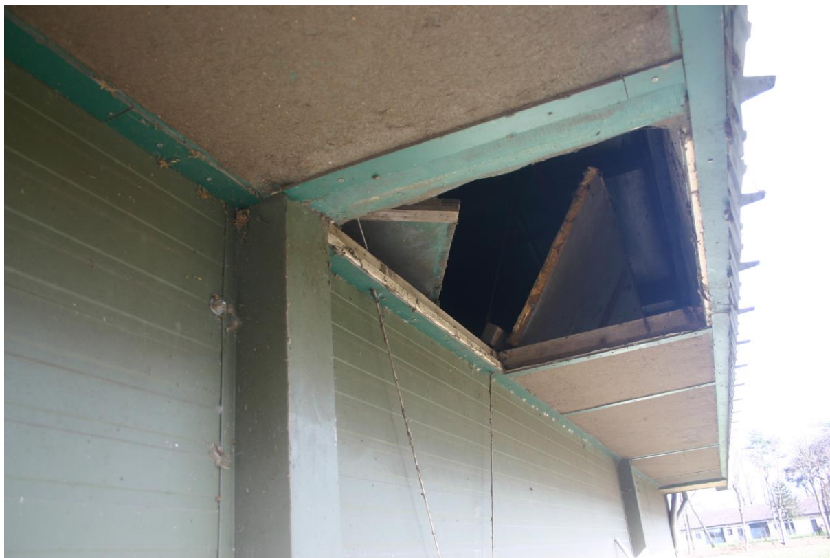
Figuur 4. Een van de plafondplaten van stal 1 ontbrak en op de zolder waren enkele holenduiven aanwezig.
