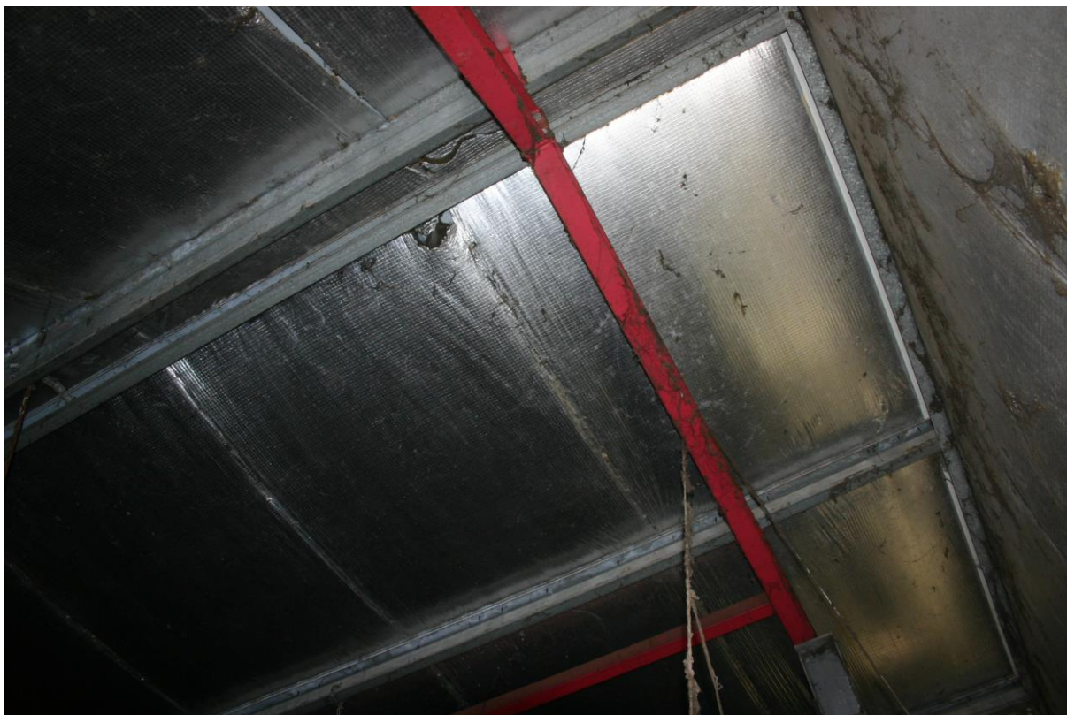
Figuur 5. Het dak van stal 1 bevat gladde folie.
