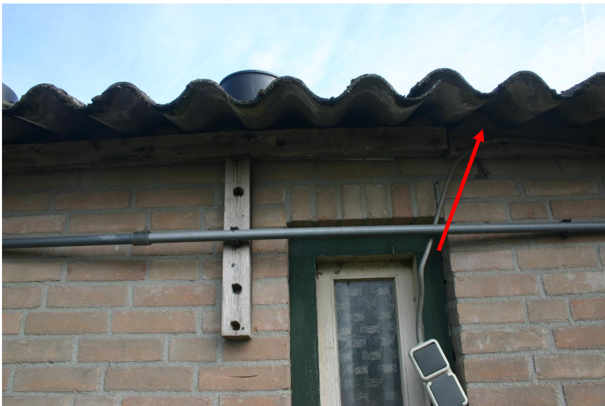
Figuur 7. Volledig geïnspecteerde opening (rode pijl) in gebouw 2.
