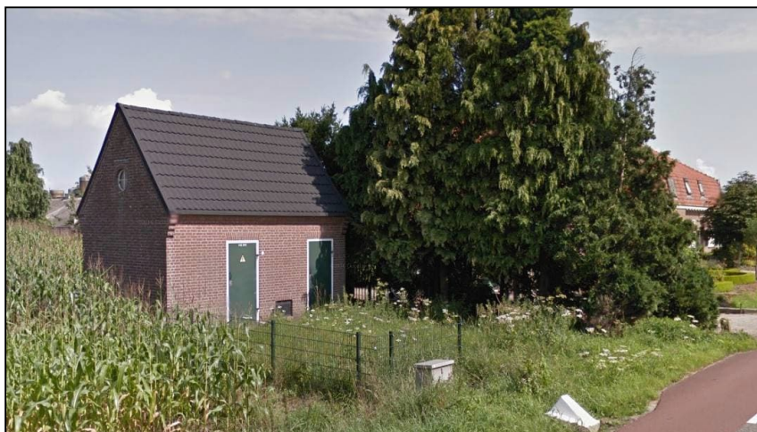
Figuur 32: Beeld transformatorhuisje ten westen van plangebied (bron: Google Maps)
