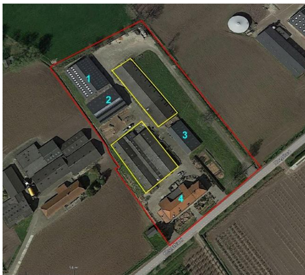
Fig.2. De bestaande situatie. Het gehele plangebied is rood omkaderd. Met de gele lijnen zijn de contouren aangegeven van de te slopen hoofdbebouwing. De bebouwing die genummerd is blijft behouden.
