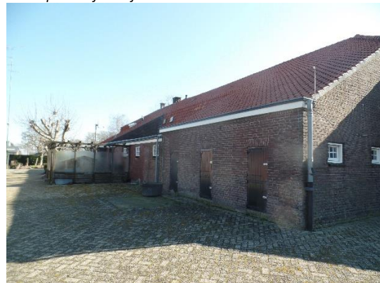
Achterkant ter hoogte van (zuid)westelijke kopgevel
