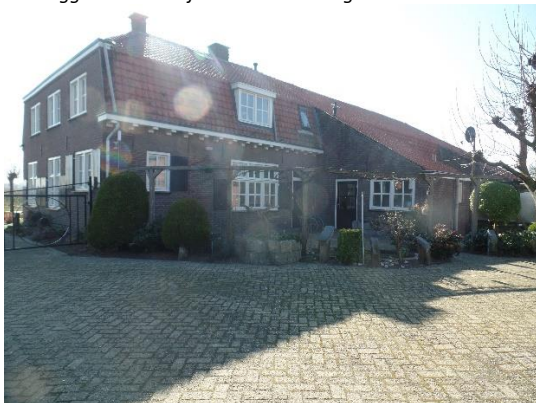
de langgevelboerderij van de achterkant gezien ter hoogte van (noord)oostelijke kopgevel
