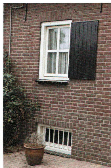
Opkamervenster met keldervenster
