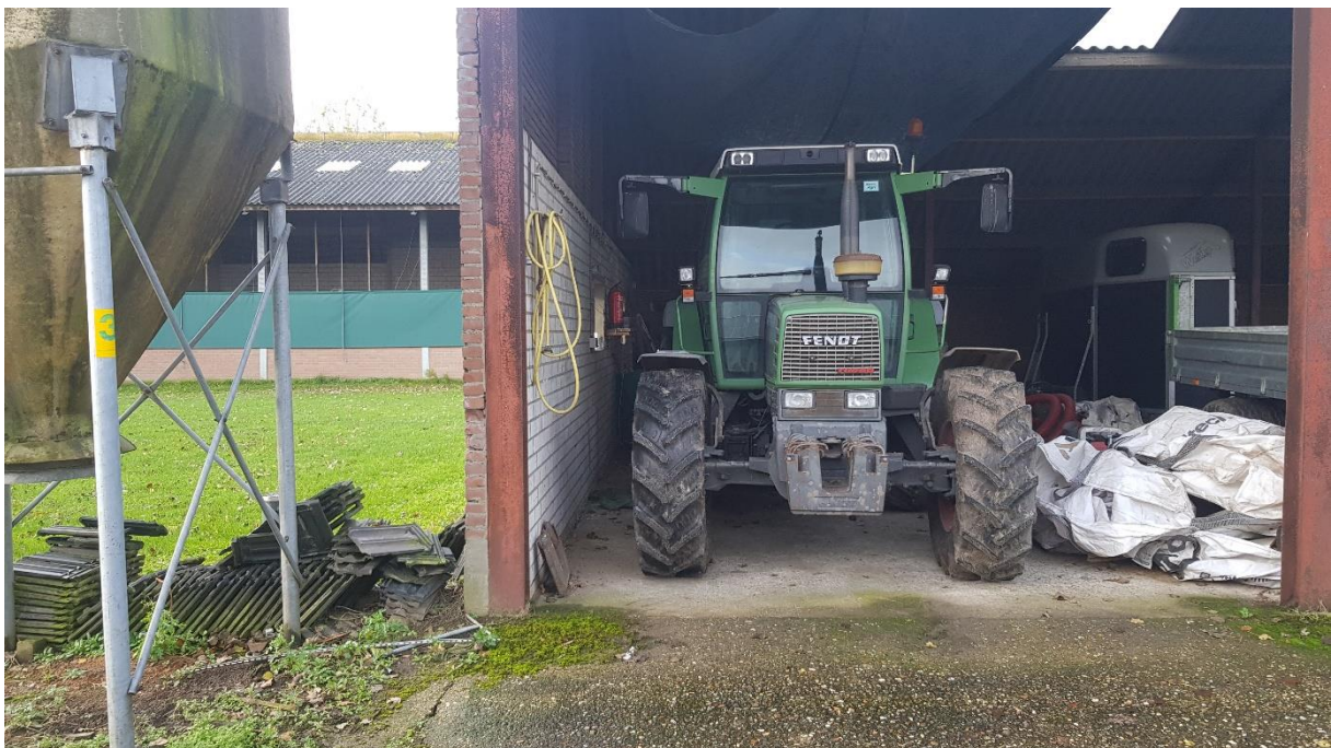
loods 2 en locatie voormalige dieseltank aan binnenzijde tegen gevel
