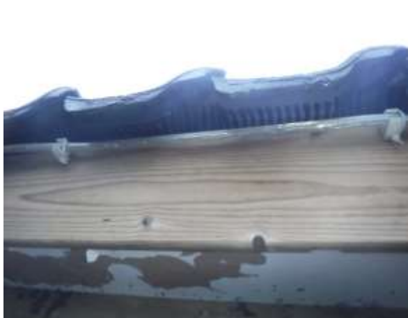
Bij de pannen daken is eveneens vogelschroot gemonteerd.
