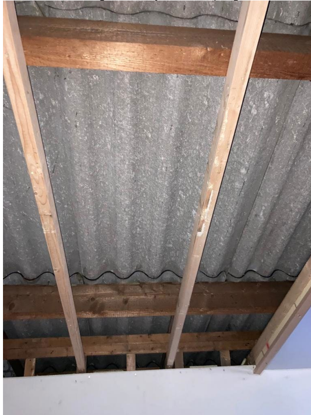
• Afbeelding 14:bovenzijde dak te slopen gebouw
