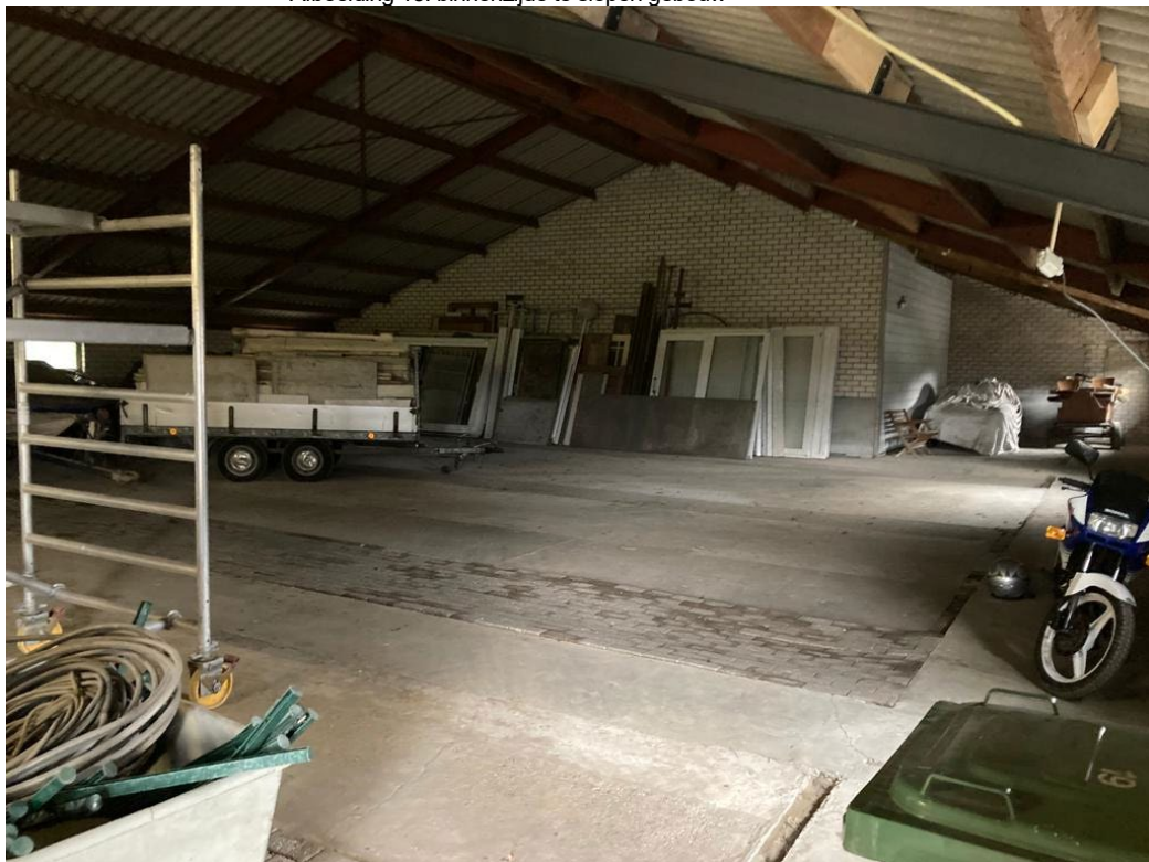
• Afbeelding 15: binnenzijde te slopen gebouw
