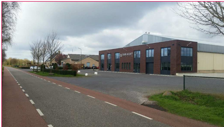
Figuur 1.1: Huidige situatie Hoogstraat (met voor het gebouw bij de witte betonblokken de weegbrug van bedrijf Van Acht).
