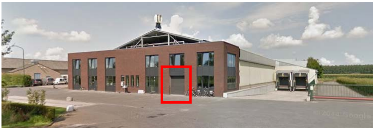
Figuur 1. Ligging overheaddeur voorzijde
