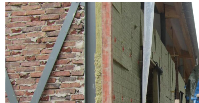
Figuur 11: Bouwfoto van paardenstallen waarop isolatie duidelijk zichtbaar is.
