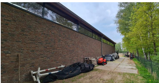
Figuur 7: Gevel van huidige stallen waar een aanbouw is voorzien
