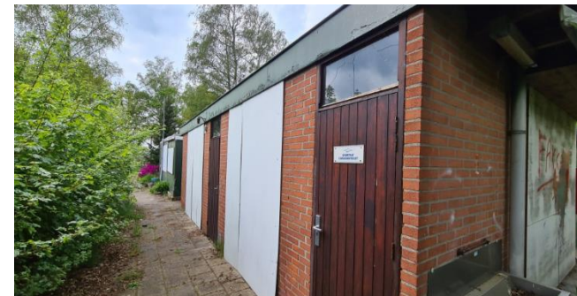
Figuur 5: Voormalig sanitair gebouw
