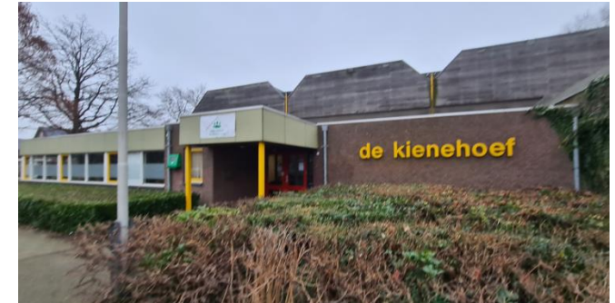
Figuur 5: Noordgevel sportzaal Kienehoef
