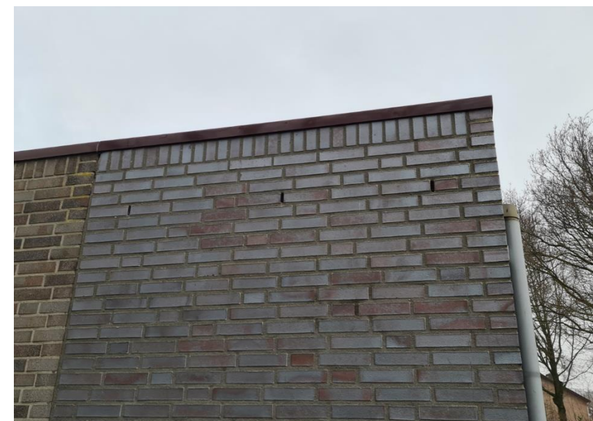
Figuur 3: Noordoostelijke gevel van de school, met open stootvoegen
