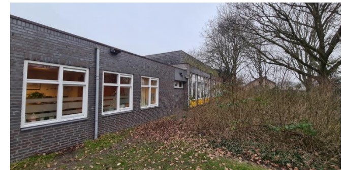
Figuur 6: Noordgevel van OBS de Springplank
