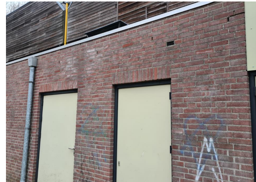
Figuur 5: Detailopname van zuidgevel
