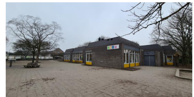
Figuur 9: Zuidgevel van OBS de Springplank
