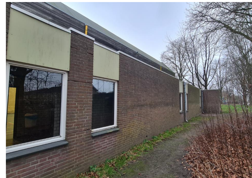
Figuur 8: Westgevel van de sporthal
