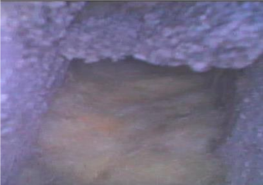
Figuur 5: Isolatiemateriaal achter de open stootvoegen
