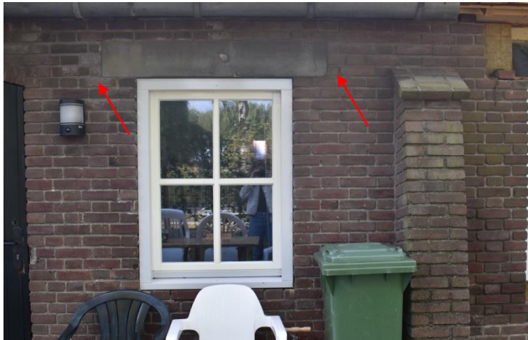
Vernieuwd vierruits venster. De rode pijl wijst de bouwsporen in het metselwerk aan.
