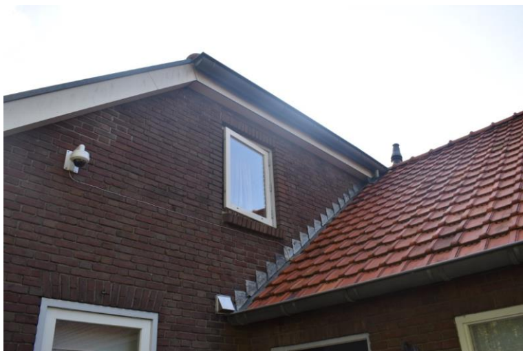
Rechterzijgevel woongedeelte met venster op de verdieping.
