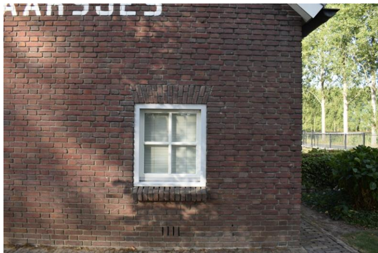
Linkerzijgevel met vernieuwd houten vierruits venster.
