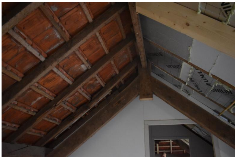
Gedeelte van het spant uit de bouwtijd in het bedrijfsgedeelte.
