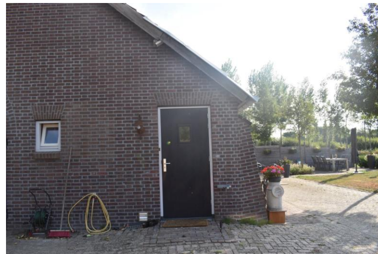
Rechterzijde van de rechterzijgevel van het bedrijfsgedeelte.
