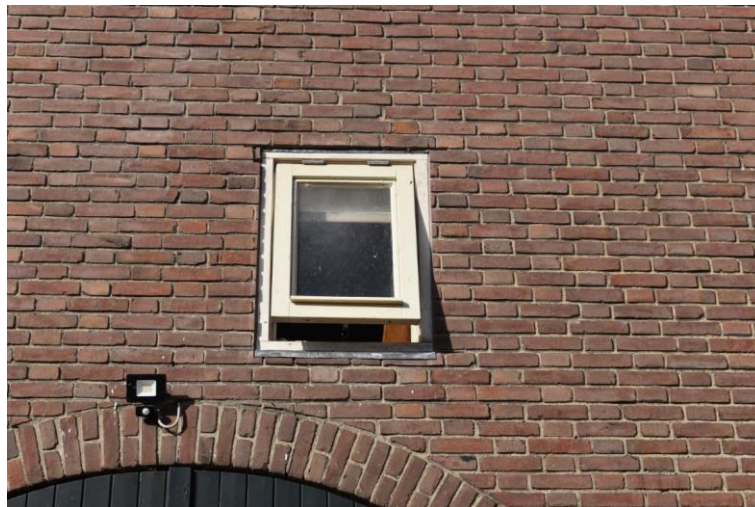
Linkerzijgevel van de verdieping van het bedrijfsgedeelte.
