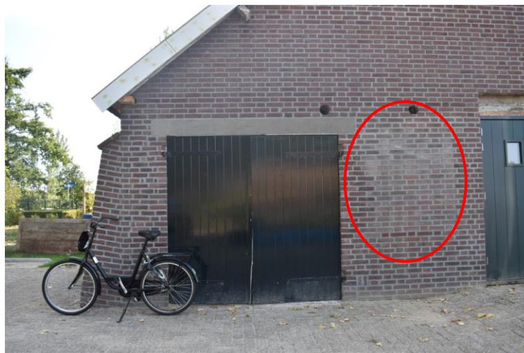
Dubbele stal deur onder betonlatei met rechts een dichtgemetselde opening (rood omcirkeld).
