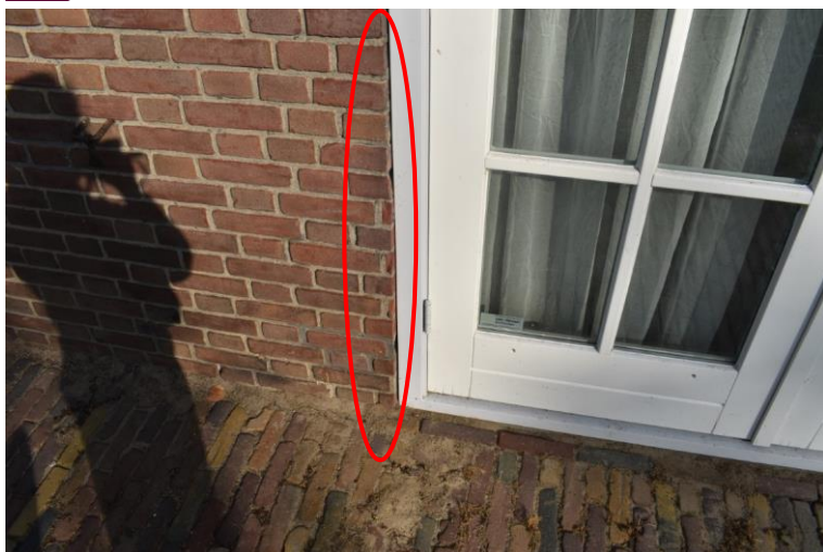
De sporen in het metselwerk zijn rood omcirkeld.
