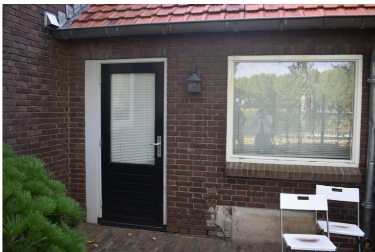
Voorgevel van het tussenlid.
