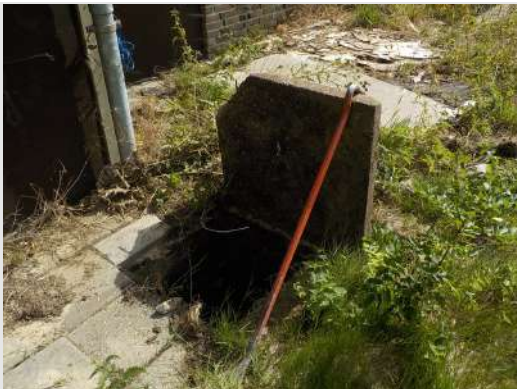
Rioolput: riolering van pvc aanwezig
