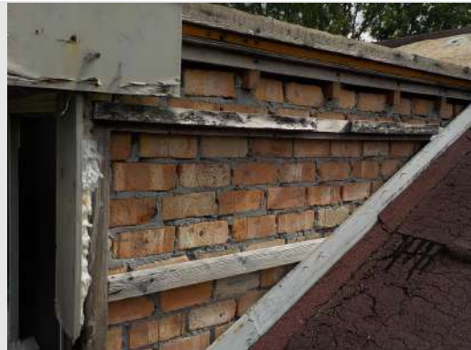
Zijwangen dakkapel, geen asbestbron
