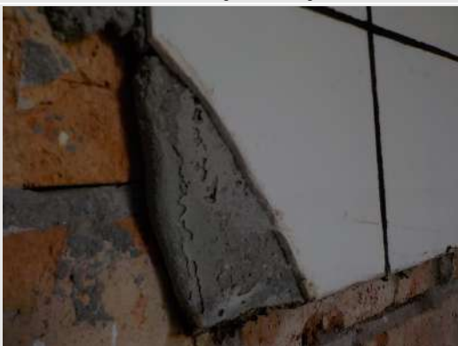
Tegelwerk: in alle ruimten in specie gezet
