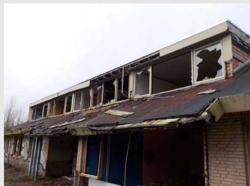
onderzoek dd 22-2-24: glas met kit op het dak
