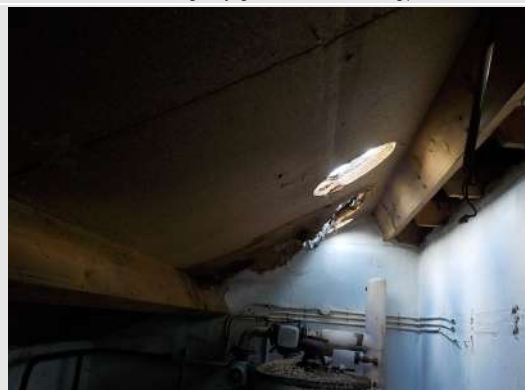
cv-ruimte: voorheen asbestplafond aanwezig, is gesaneerd
