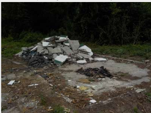
Voormalige stal, volledig gesloopt. In 2011 zijn daar geen asbestbronnen aangetroffen
