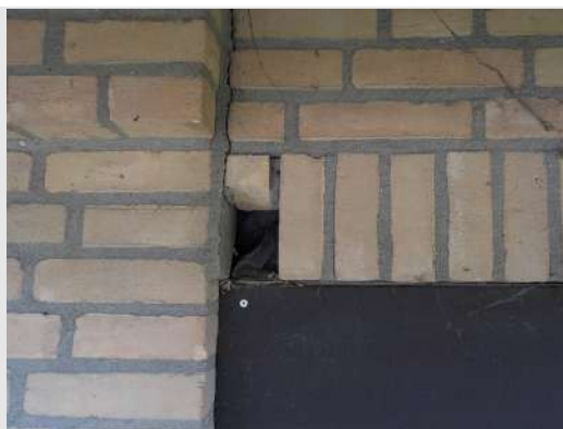
Spouwblad: loodslabbe boven de kozijnen
