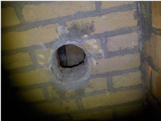
In de woonkamer is in de opengebroken schoorsteenschacht een ronde gresbuis aanwezig, geen asbestbron
