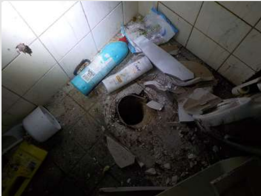
Riolering van pvc (linker woonvleugel)
