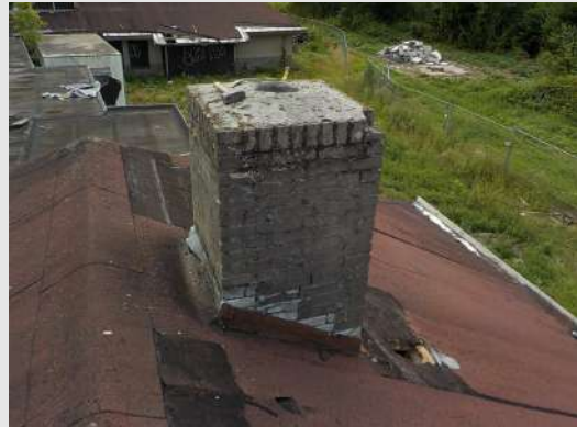
In de schoorsteenschacht is een met specie afgesmeerd kanaal aanwezig, geen asbestbron
