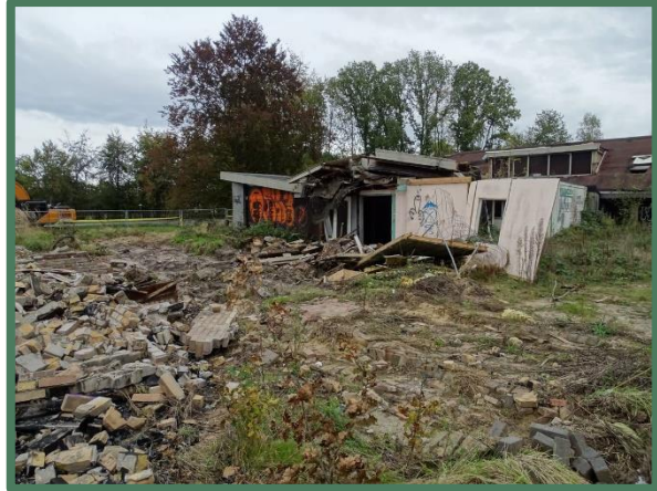
Overzicht te slopen bijgebouwen
