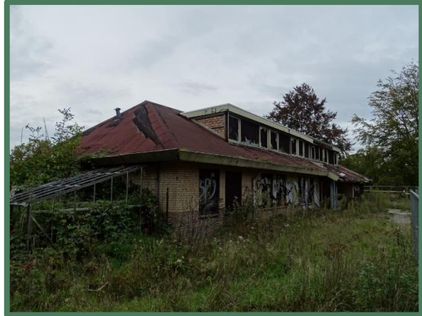
Overzicht oostzijde te slopen
