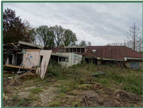
Overzicht westzijde te slopen hoofdgebouw
