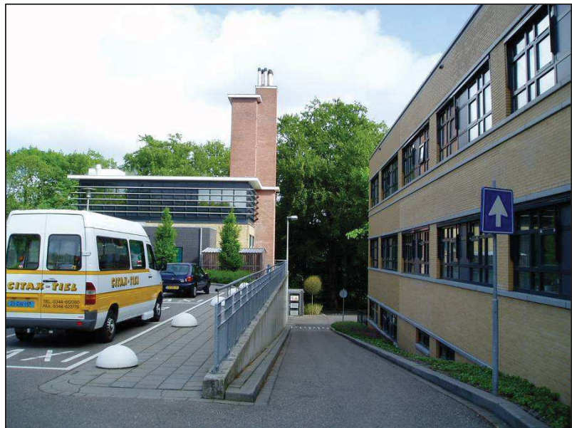
richting Technische Dienst (souterrain) / gebouw B
