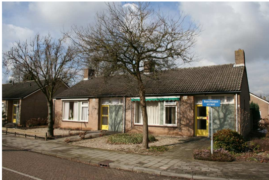
De huidige seniorenwoningen, uitgevoerd in één bouwlaag
