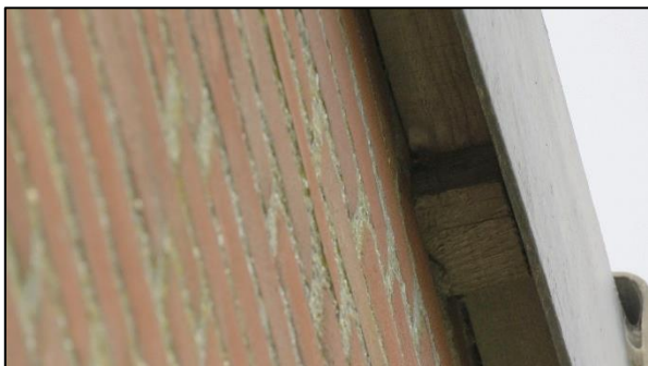
Foto 9. Dakrand van gebouw 2
