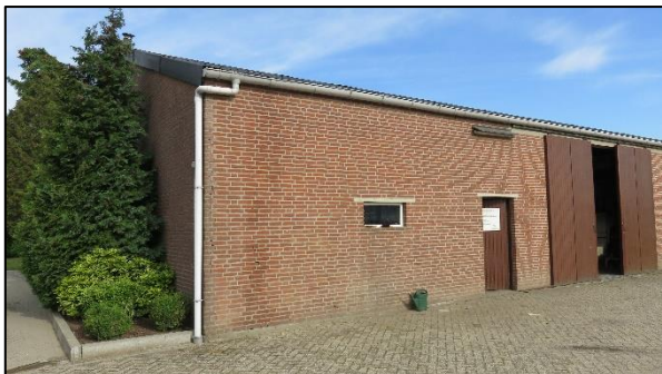
Foto 7. Oostzijde van gebouw 2
