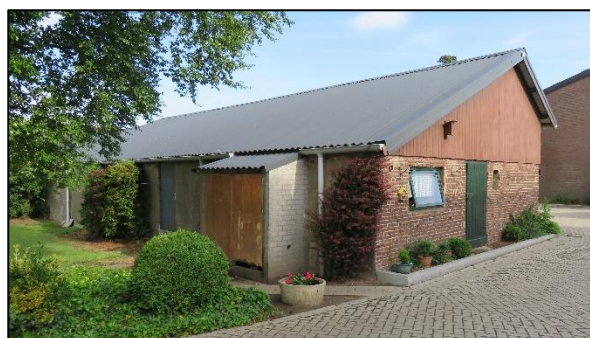
Foto 4. Zuidoostzijde van gebouw 1
