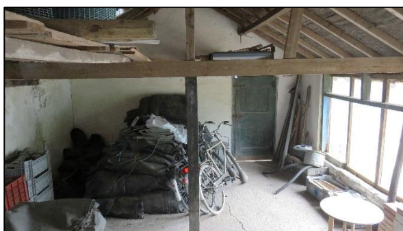
Foto 14. Binnenkant van gebouw 4
