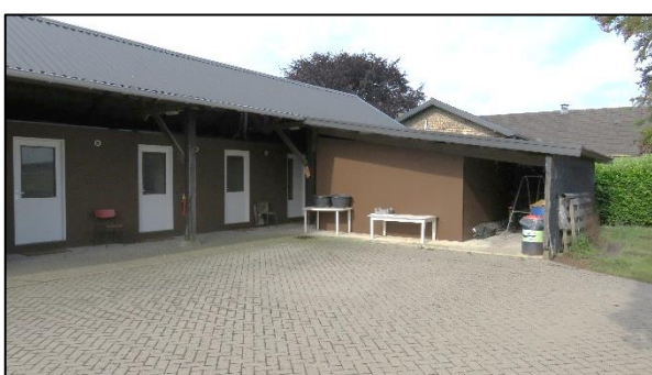
Foto 5. Noordoostzijde van gebouw 1
