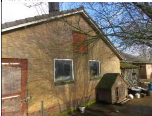
Foto 5: Toegang tot gebouw 3
