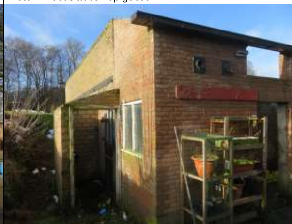
Foto 6: Gebouw 4 reeds deels ontmanteld
