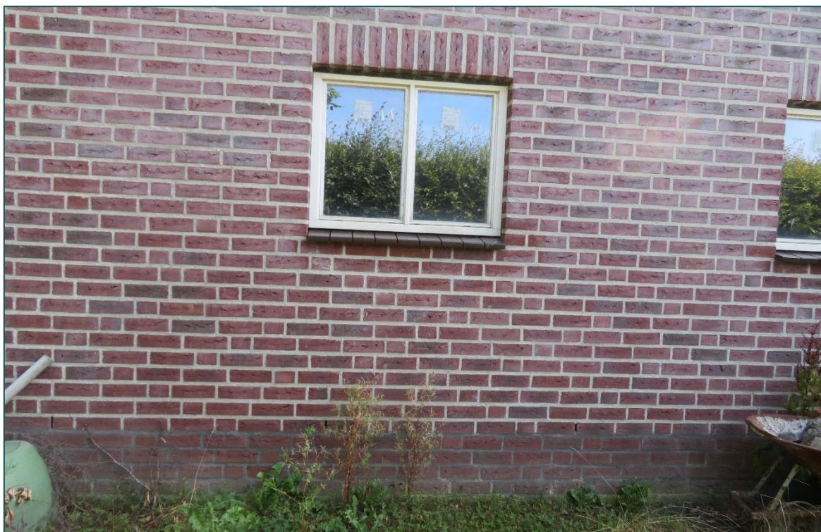
Figuur 2 De bebouwing bestaat uit gemetselde muren met spouw en is voorzien van een golfplaten dak.
