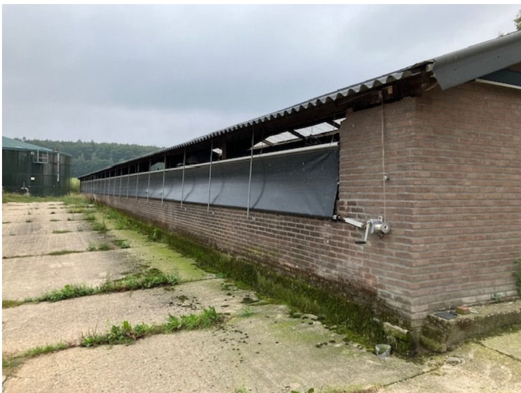
• Afbeelding 8: Linker zijgevel te slopen ligboxenstal
