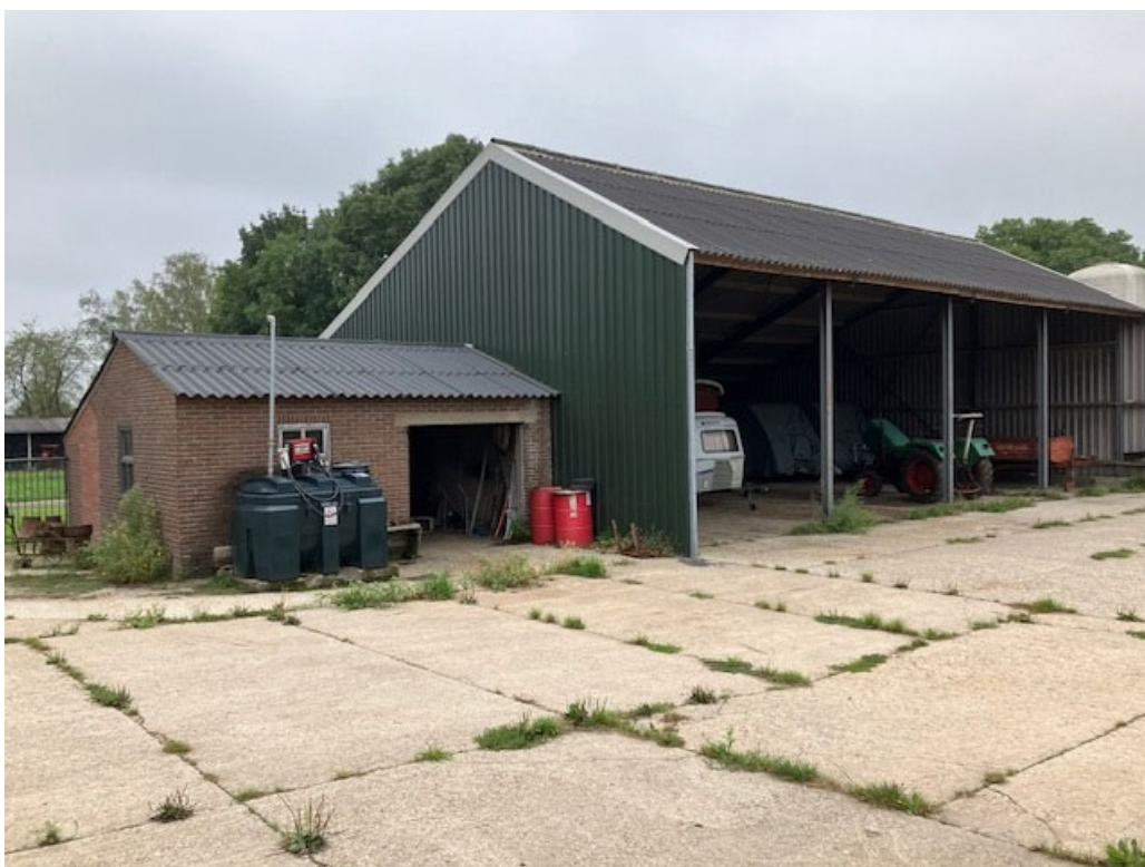
• Afbeelding 9: Loods wordt verplaatst, bijgebouw wordt gesloopt
