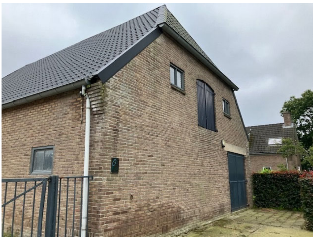
• Afbeelding 26: Voorzijde schuur, blijft behouden
