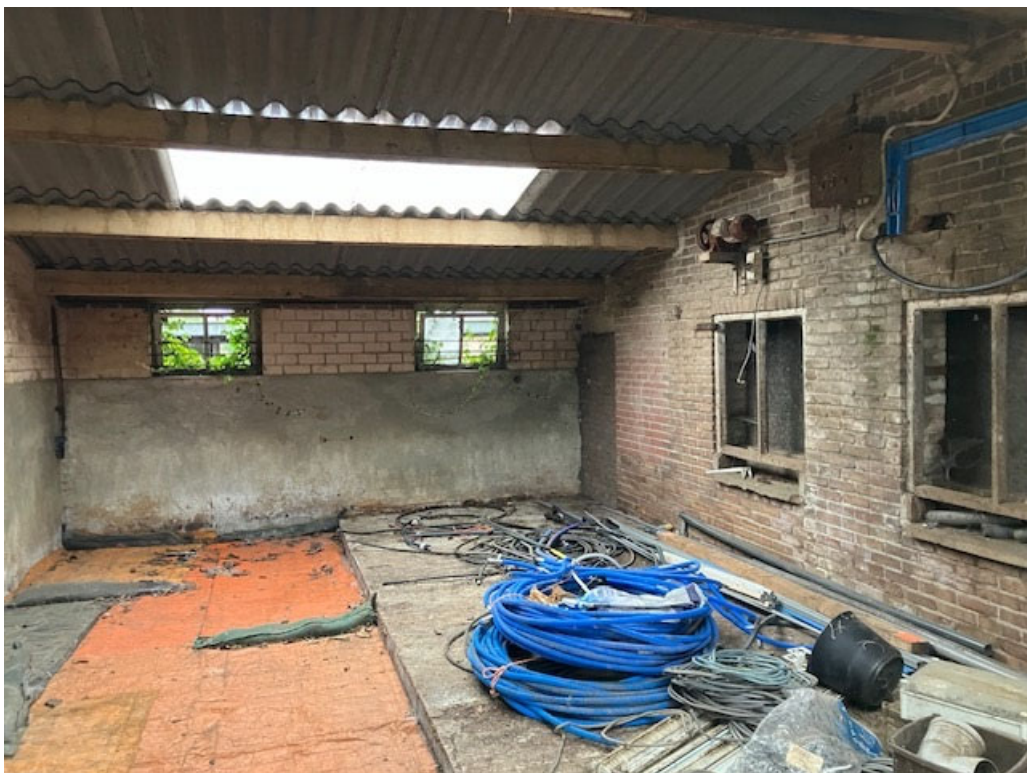
• Afbeelding 13: Tussenstuk tussen te behouden bijgebouw (rechts) en ligboxenstal. Dit wordt gesloopt
