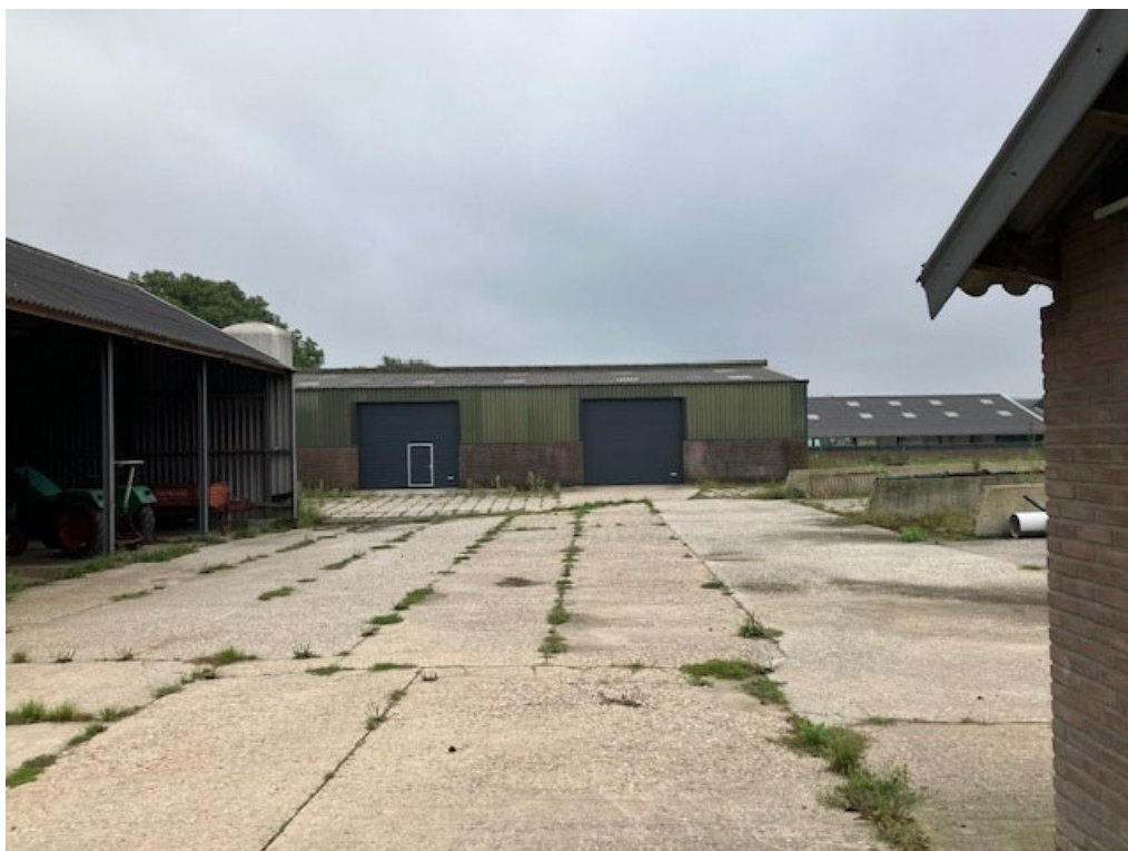
• Afbeelding 10: Erf met betonplaten, achter een te slopen jongveestal
