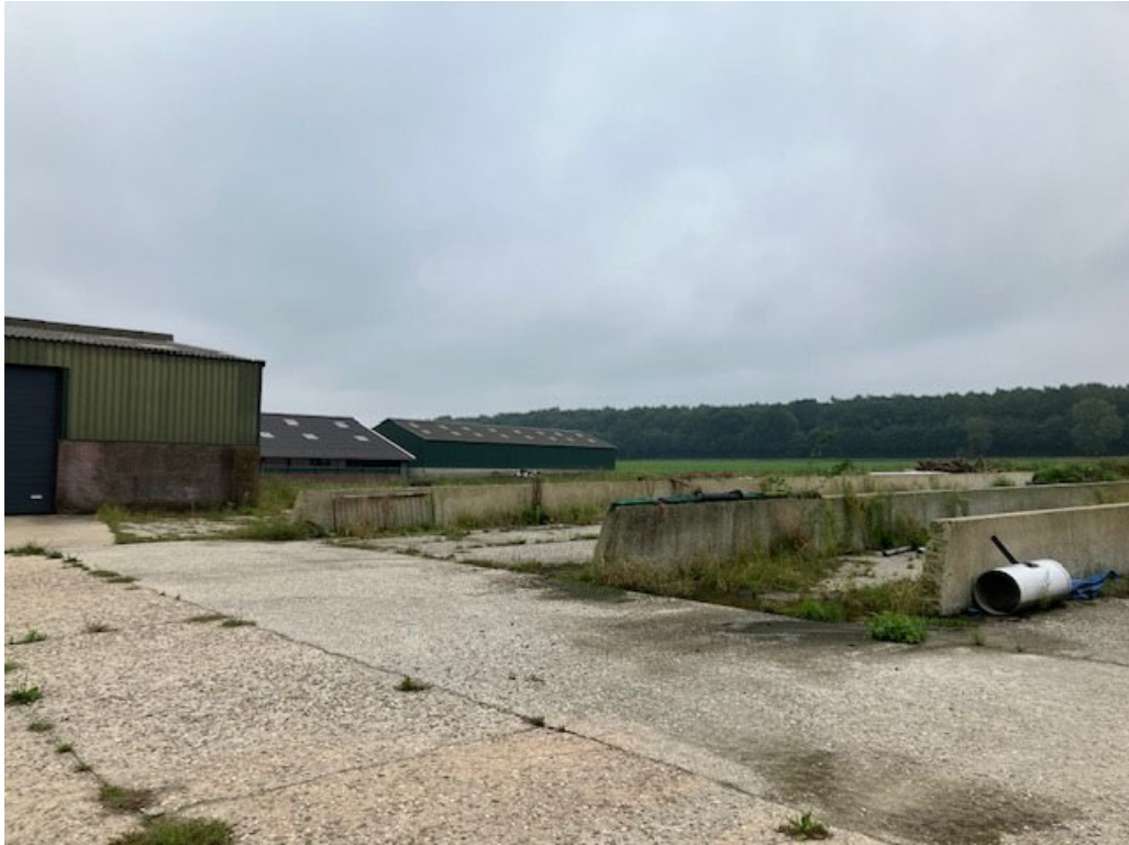
• Afbeelding 17: Sleufsilo's en te slopen jongveestal links
