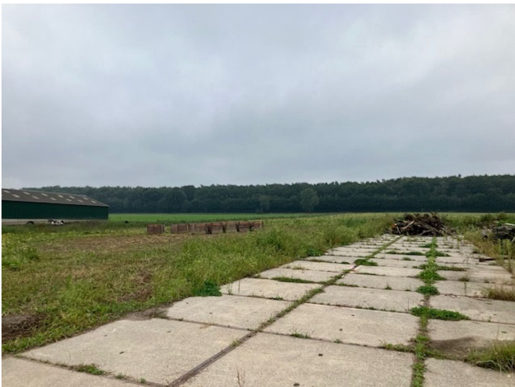
• Afbeelding 24: Erfverharding van (stelcon)betonplaten
