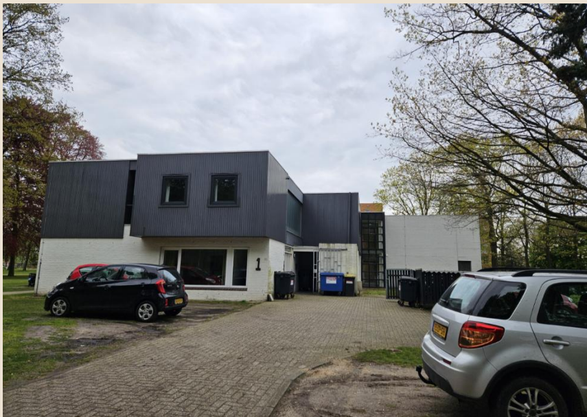
Figuur 36: Locatie 10, gezien vanuit het oosten
