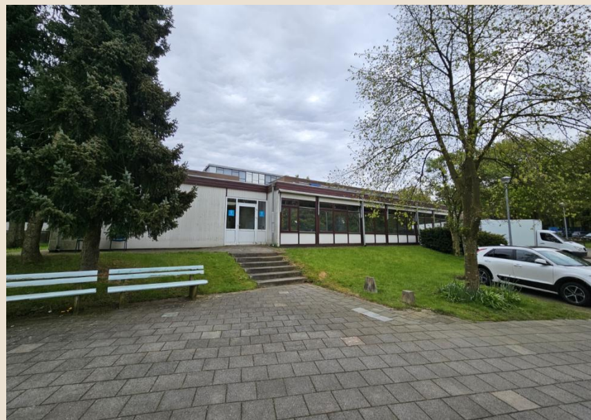
Figuur 52: Locatie 13, magazijn GGZ, gezien vanuit het oosten
