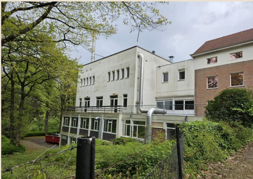
Figuur 30: Locatie 7, gezien vanuit het zuidoosten
