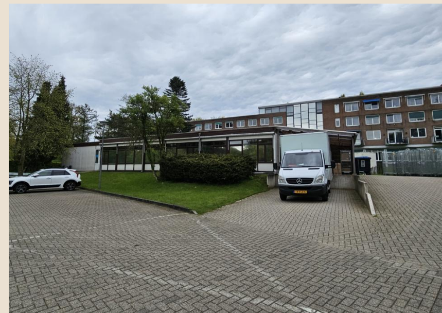
Figuur 53: Locatie 13, magazijn GGZ, gezien vanuit het zuidoosten
