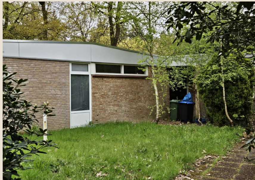
Figuur 43: Locatie 12, gezien vanuit het oosten
