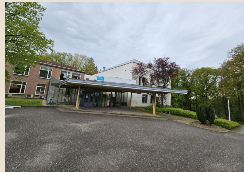
Figuur 29: Locatie 6, gezien vanuit het noordwesten
