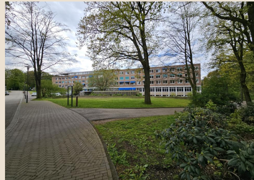
Figuur 50: Locatie 13, Kentering, gezien vanuit het oosten
