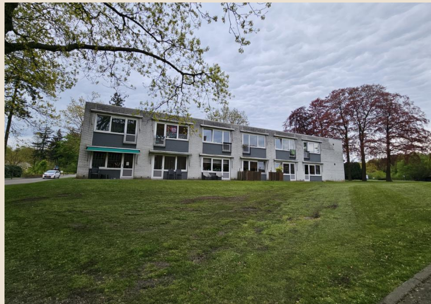
Figuur 37: Locatie 10, gezien vanuit het westen
