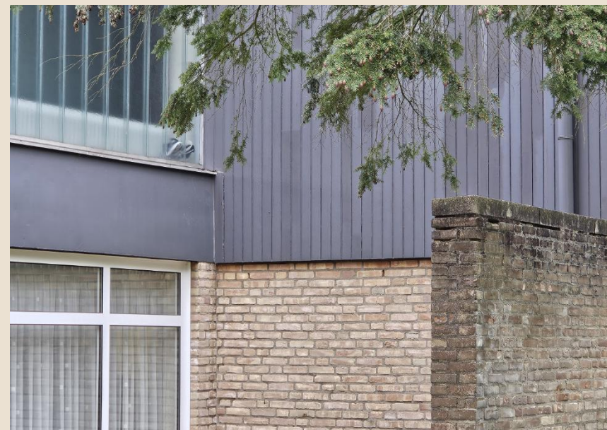
Figuur 41: Locatie 11, gezien vanuit het oosten
