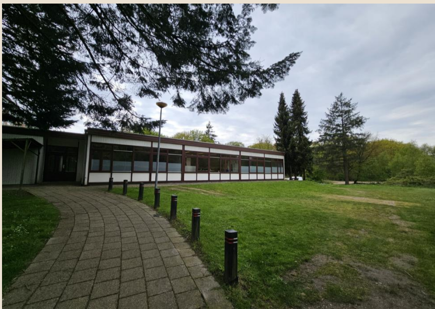
Figuur 51: Locatie 13, magazijn GGZ, gezien vanuit het noordwesten
