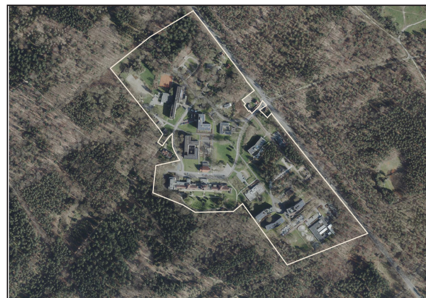
Figuur 1: Plangebied op luchtfoto
