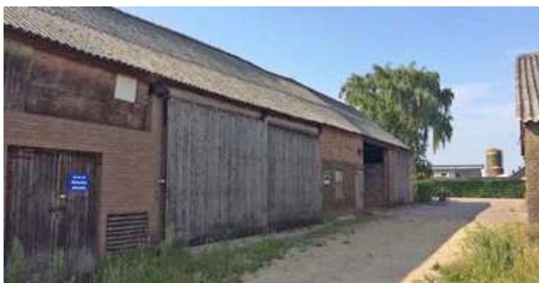
Foto's bestaande situatie plangebied. V.b.n.b woonhuis, te verbouwen schuur, te herbouwen mestilo, deels te slopen schuur.
