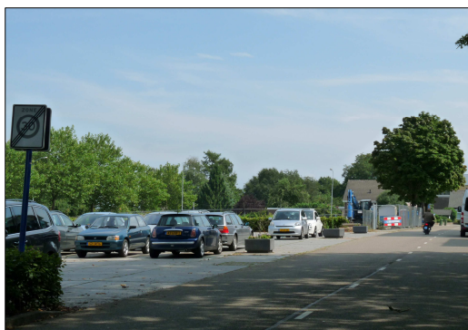
Parkeerplaatsen aan de oostzijde van de bestaande winkelpanden met de bouwplaats op de achtergrond.
