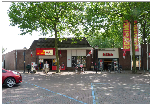
Aanzicht voorzijde bestaande winkelpanden aan de westzijde van het besluitgebied.
