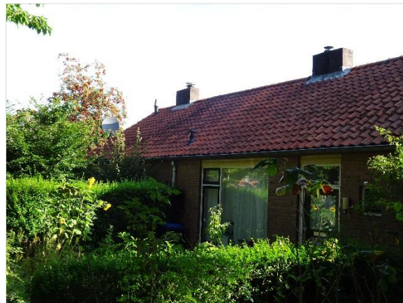
Figuur 1.4 Voorzijde van een woonblok op de projectlocatie.
