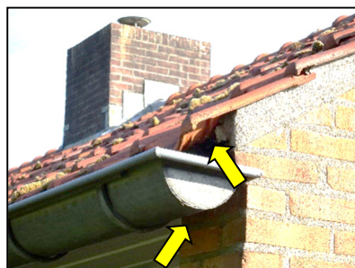
Figuur 7. Voorbeeld van ruimte onder de dakpannen en tussen dakgoot en gevel.
