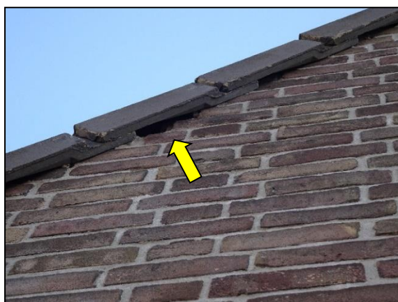
Figuur 9 Ruimten tussen de overhangende dakpannen bieden geschikte openingen voor gierzwaluw en huismus.
