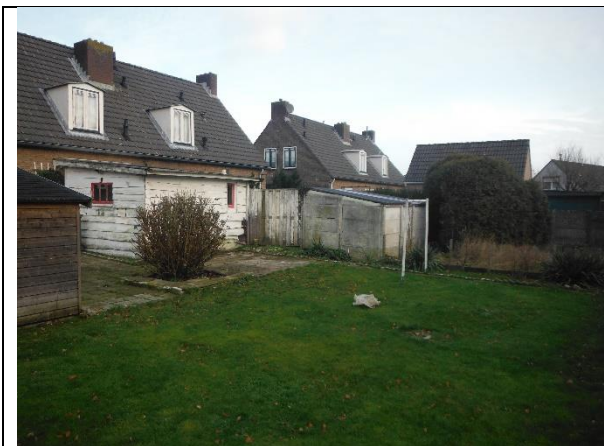
Vanuit zuidelijke richting nabij boring 2
