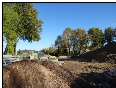
Figuur 7. Overzicht op de bouwlocatie.
